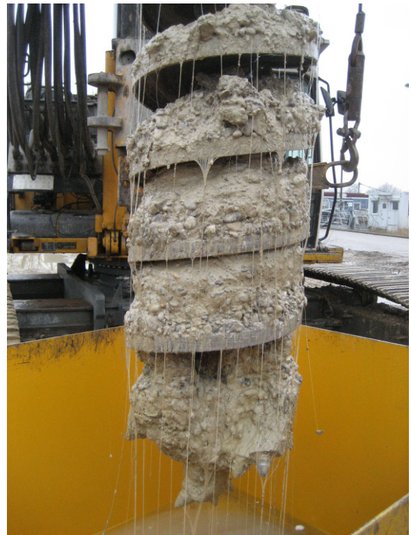
Abbildung D.26: gefüllte Bohrschnecke
