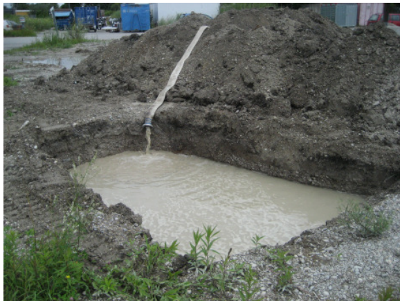
Abbildung D.55: Versickerungsbecken für Wasserhaltung
