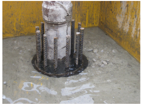
Abbildung D.34: Einführen des Betonierrohrs
