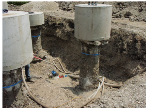
Abbildung D.54: Wasserhaltung und freigelegte Pfähle
