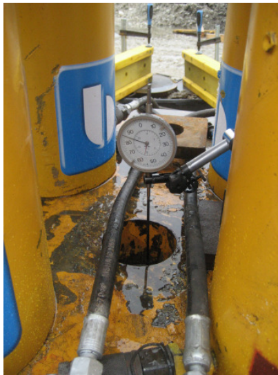
Abbildung D.51: Messen der Anlege- setzung des Stahlblechs am Kopf des Druckpfahls
