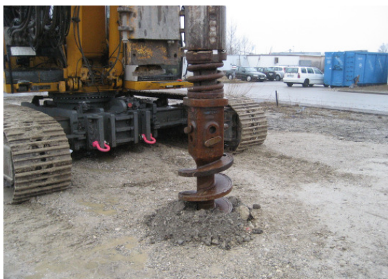
Abbildung 15: Vorbohren für Ansatzverrohrung
