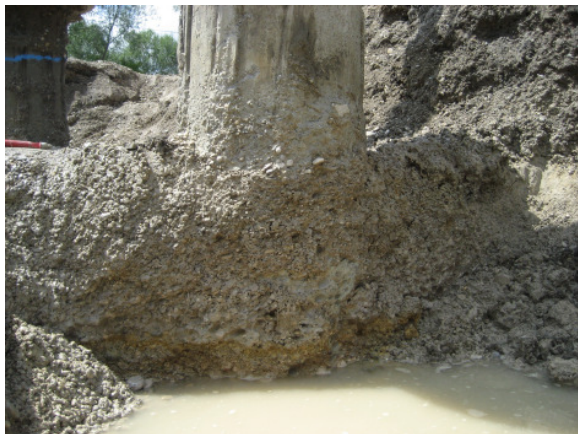
Abbildung D.57: Freilegen von Pfahl P 3 (unter Bentonitstützung hergestellt)
