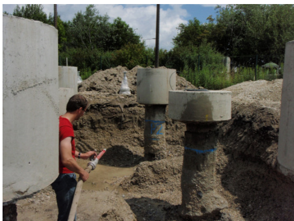
Abbildung D.59: Abspritzen der Pfähle
