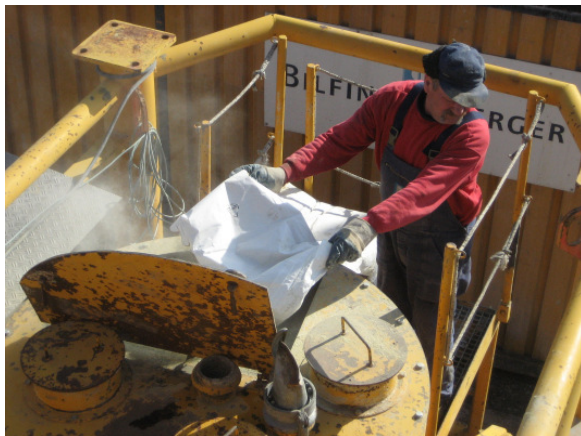
Abbildung D.43: Zugabe von Hand des Bentonits zur Mischanlage
