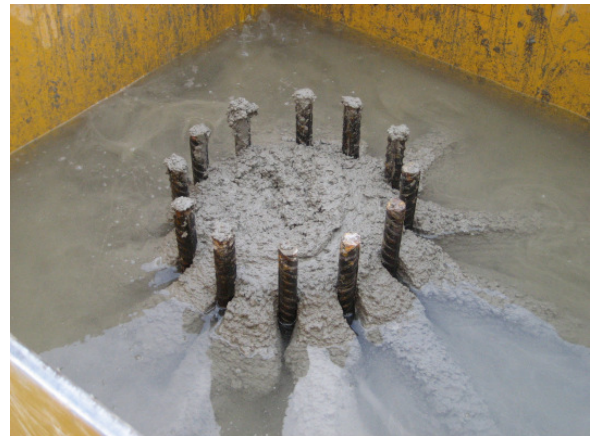
Abbildung D.36: Pfahlkopf nach Ende des Betonierens
