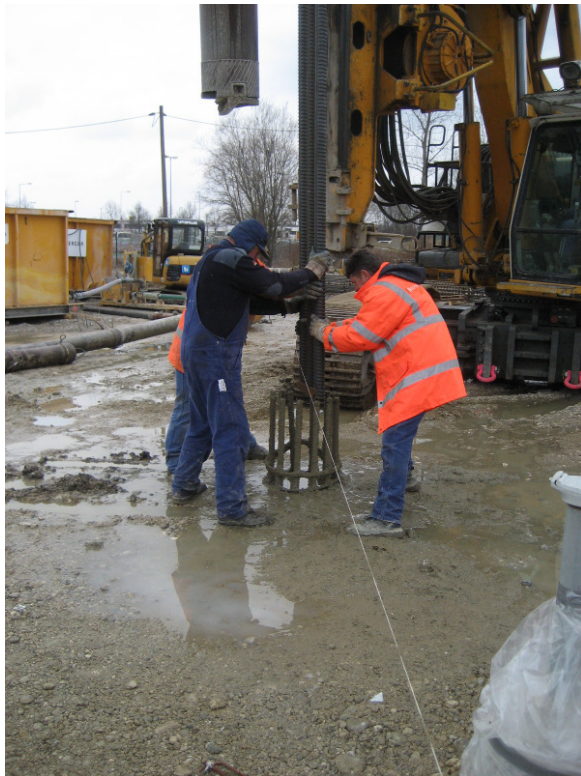
Abbildung D.37: Einsetzen von GEWI-Stäben nach dem Betonieren eines Zugpfahls
