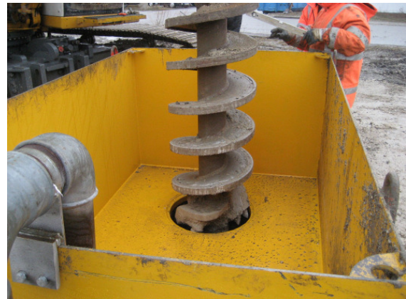
Abbildung D.18: Bohrschnecke beim Einfahren ins Bohrloch
