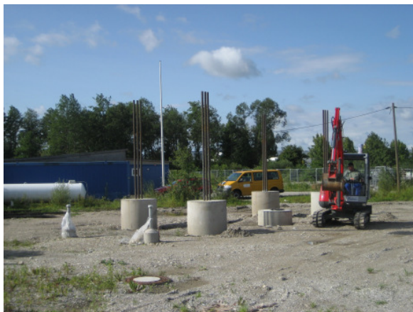
Abbildung D.53: Freilegen der Pfähle mit Mini- bagger
