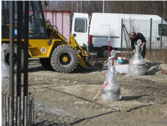
Abbildung D.41: Grundwasserbeprobung während der Bauphase
