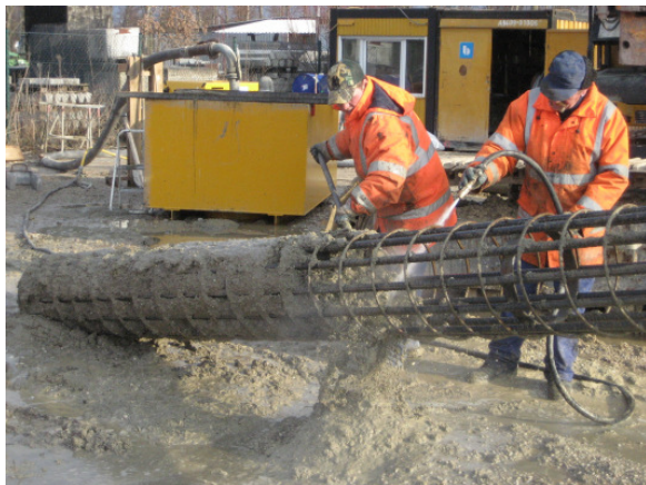
Abbildung D.39: Reinigen des geborgenen Bewehrungskorbs (Pfahl P 1)
