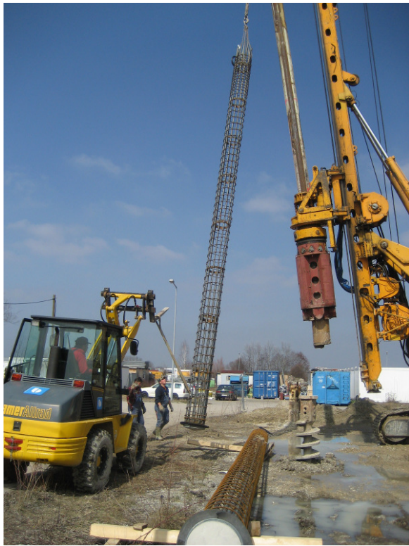
Abbildung D.33: Bewehrungskorb für Druckpfahl
