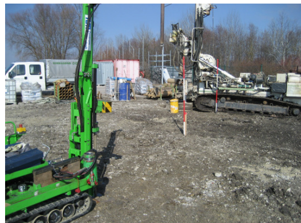
Abbildung D.2: Baugrunderkundung (DPH)
