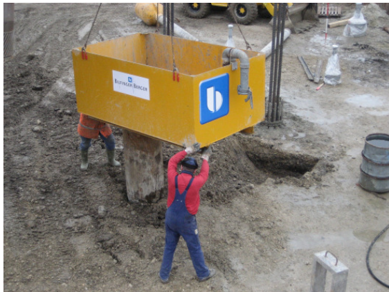
Abbildung D.17: Einsetzen des Oberbeckens am Bohransatzpunkt
