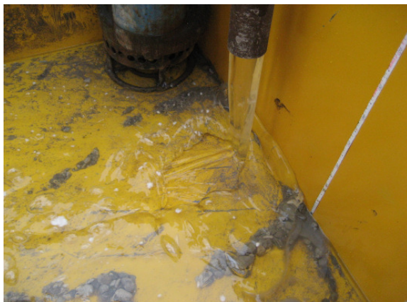
Abbildung D.19: Einleiten der Stützflüssigkeit (einzelne Polymerflocken erkennbar)
