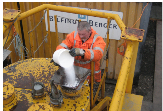
Abbildung D.14: Zugabe des Polymers zur Mischanlage
