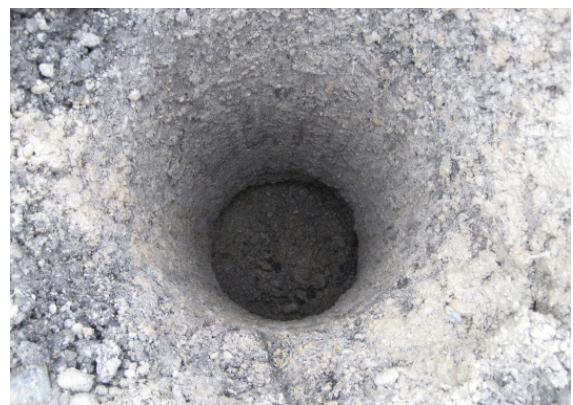
Abbildung 16: Vorbohrung (leichter Nachfall im Sohlbereich erkennbar)
