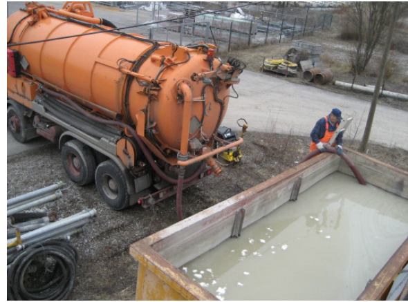
Abbildung D.42: Abholung von Restflüssigkeit durch Saugwagen (Entsorgung in Kläranlage)
