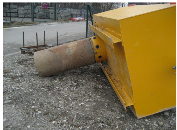
Abbildung D.10: Oberbecken Bohrloch mit angekuppelter Ansatzverrohrung
