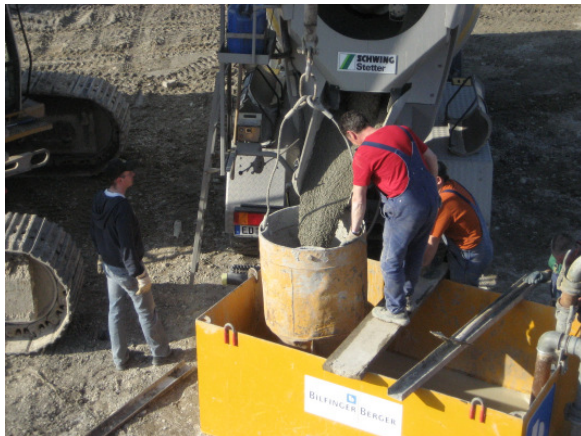
Abbildung D.35: Betonieren im Kontraktorverfahren
