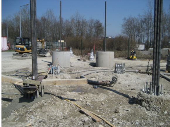
Abbildung D.47: Pfahlkopfweiterungen durch ausbetonierte Schachtringe
