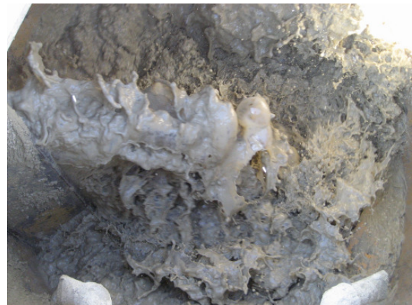
Abbildung D.44: Bentonitsuspension in der Mischanlage
