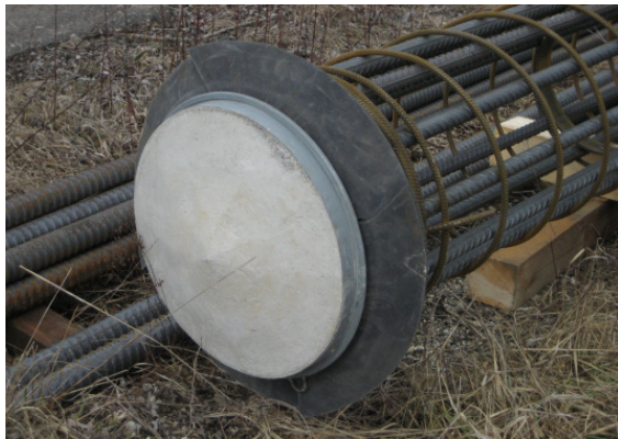
Abbildung D.11: Pfahlfußdose an Bewehrungskorb montiert (Unterseite)
