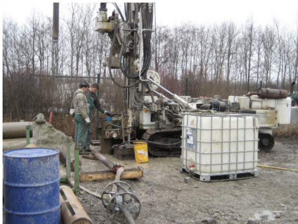
Abbildung D.1: Baugrunderkundung (GWM)
