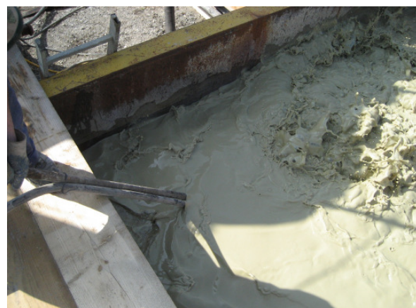
Abbildung D.46: Durchmischen der Bentonitsuspension mit Druckluft
