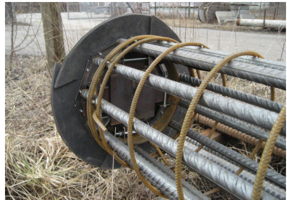
Abbildung D.12: Pfahlfußdose an Bewehrungskorb montiert (Oberseite)
