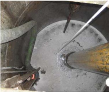
Blick in ein Bohrloch während des Betoniervorgangs (Der obere Bereich des Bohrlochs wird aufgrund der hohen Verkehrslasten meist durch eine Verrohrung gesichert, der untere Bereich wird hier ausschließlich durch die Stützflüssigkeit stabilisiert.)
