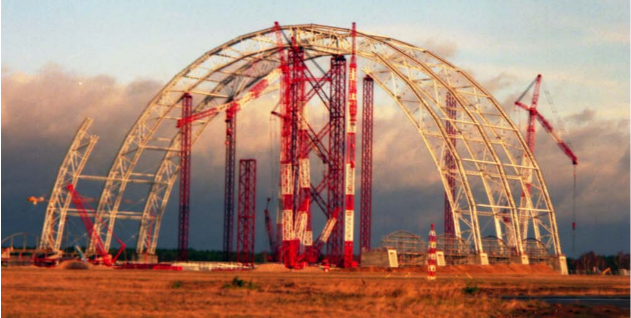
Abb.12: Montage der Stahlbögen
