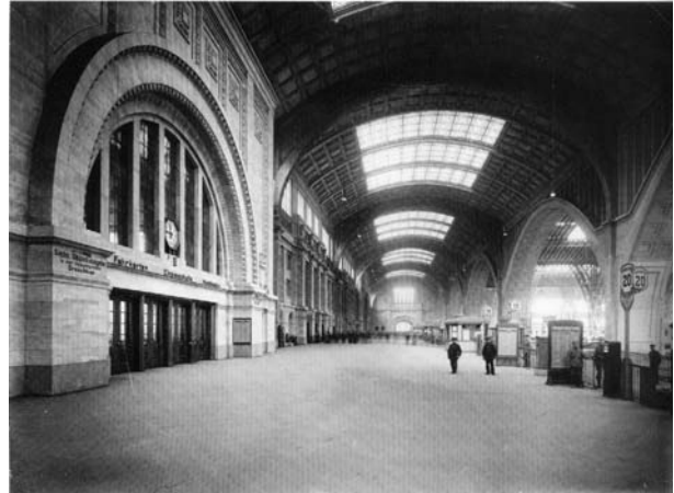
Bild 3: Querbahnsteigehalle Hauptbahnhof Leipzig (1913)
