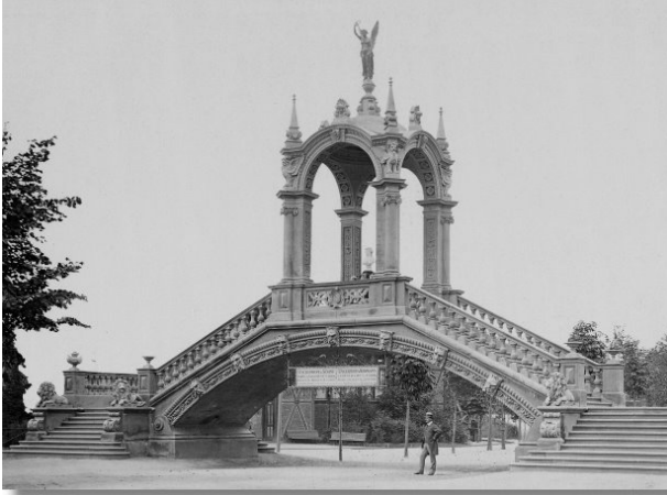
Bild 2: Die erste Betonbrücke Deutschlands auf der Kunst- und Gewerbeausstellung 1880 in Düsseldorf. Errichtet von Eugen Dyckerhoff und den Zementwerken Dyckerhoff & Söhne [Stadtarchiv Wiesbaden]
