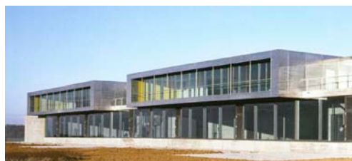
Abb.84: Westfassade [Nagi 05] S.1439
