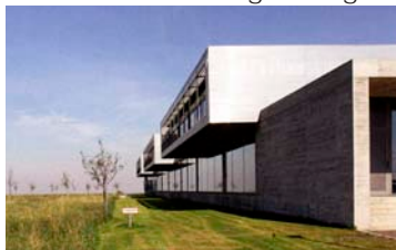
Abb.83: Blick entlang Fassade [Dam 06]
