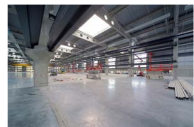
Abb.118: Produktionshalle [Hemp 08] S. 23
