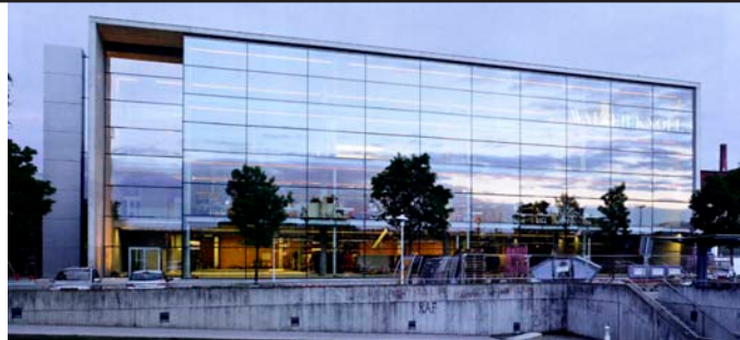
Abb.86: Sicht auf Glasfassade [Frie 07] S.26-29
