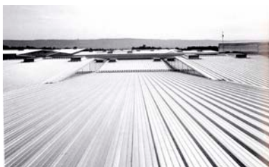
Abb.4: Blick auf das Dach [Adam 04] S.122
