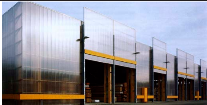
Abb.6: Ansicht der Halle [Nagl 01] S.440
