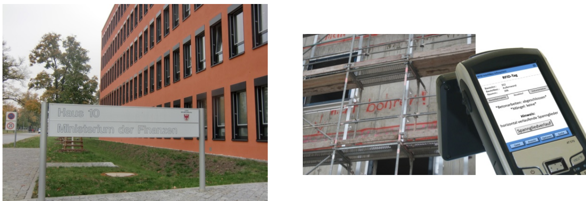
Abbildung 3: Anwendung der RFID-Technologie während der Bauphase
