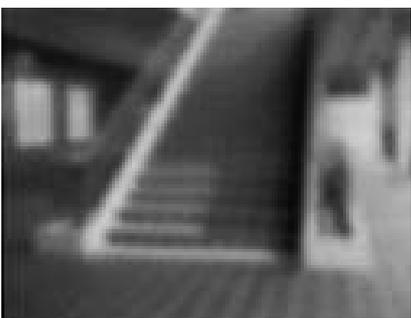
Gegenüberstellung der visuellen Wahrnehmung von Treppenläufen bei normalem und reduziertem Sehvermögen. Die einzelnen Stufen werden infolge Kontrastbildung zwischen Tritt- und Setzstufen bzw. Treppenantritt und Treppenlauf sowie zwischen Treppenwange und Treppenlauf visuell erkennbar
