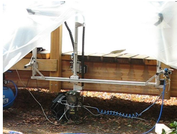
Bild 99 Betrieb des Baustellenscanners mit A1220-Interface
