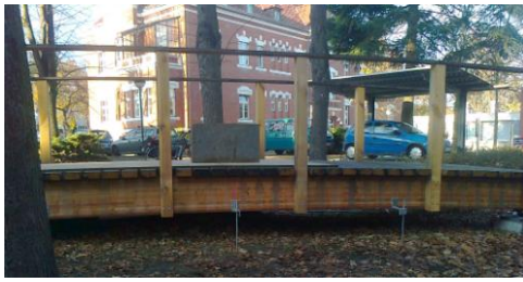
Bild 94 Fußgängerbrücke Fabeckstraße (Seitenansicht)
