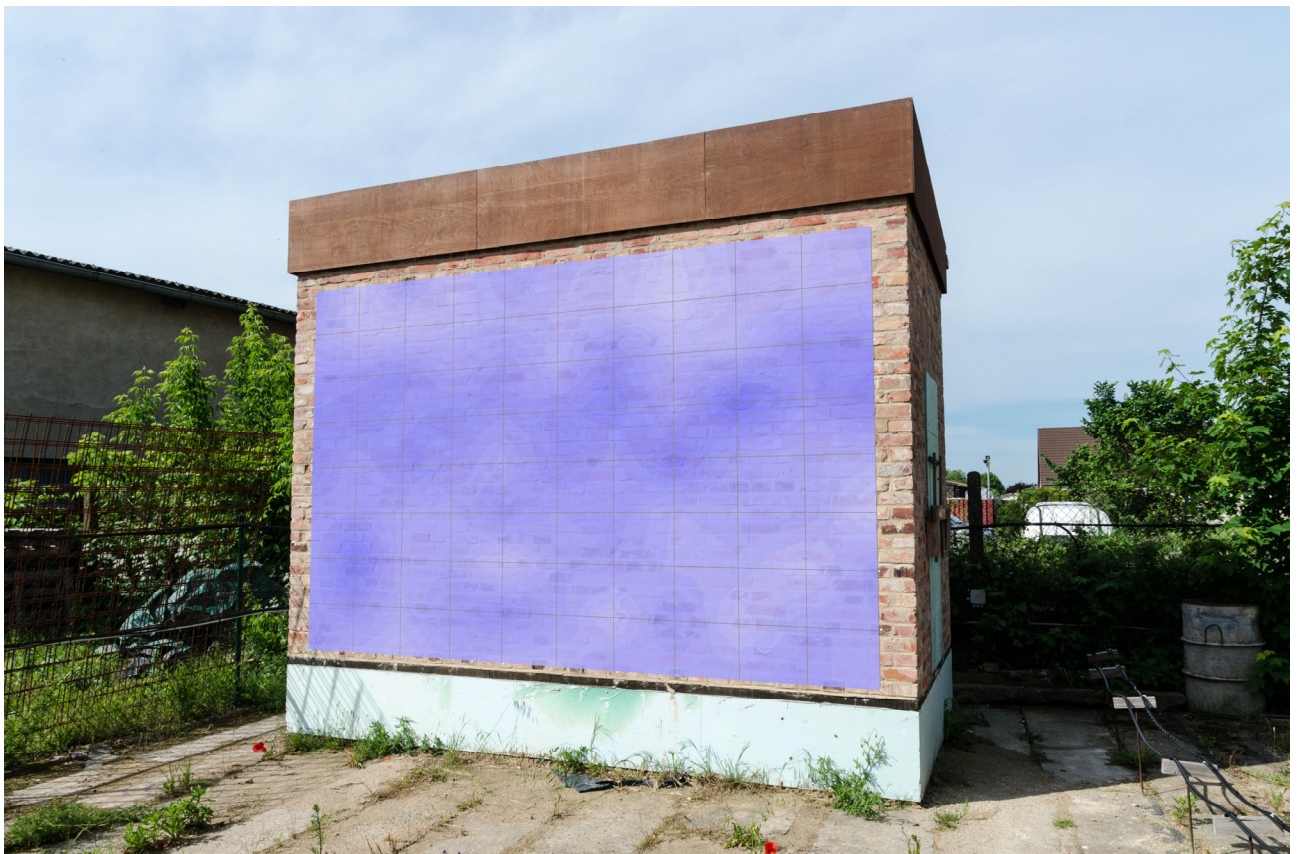
Versuchsgebäude 2 Ostseite, Mikrowellenmessung Messkopf PM 26.10.2017
