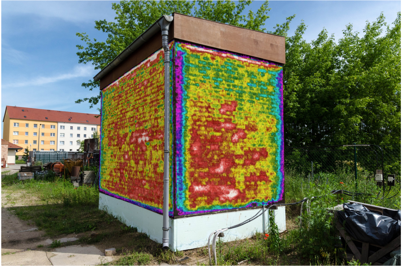
Versuchsgebäude 4 Südseite, Thermografie 07.06.2017
