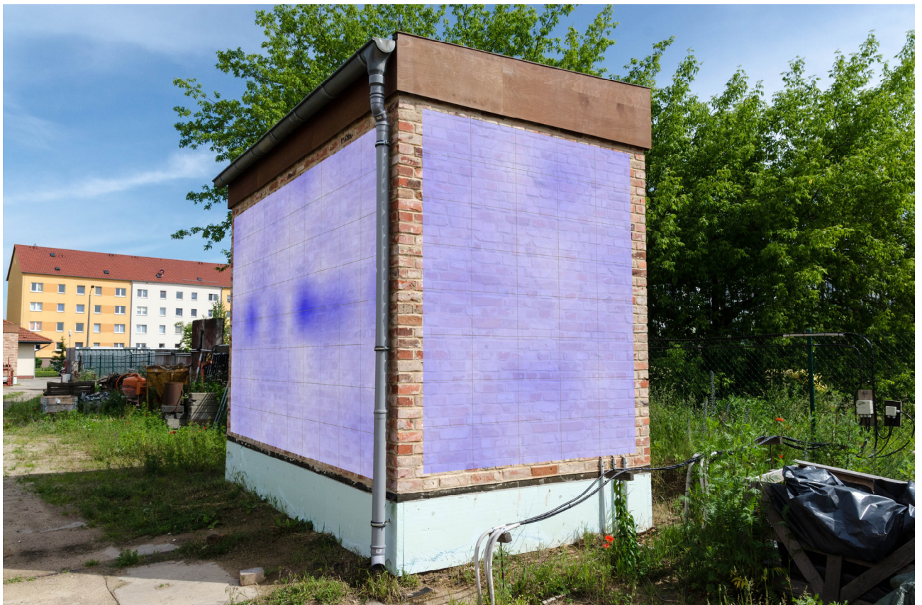
Versuchsgebäude 4 Südseite, Mikrowellenmessung Messkopf PM 06.06.2017
