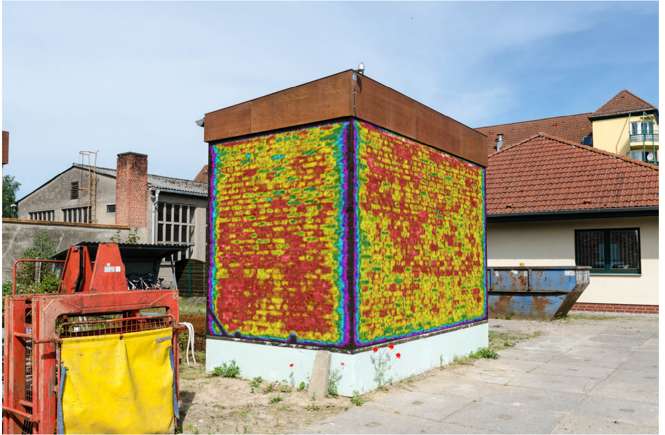
Versuchsgebäude 1 Ostseite, Thermografie 10.06.2017
