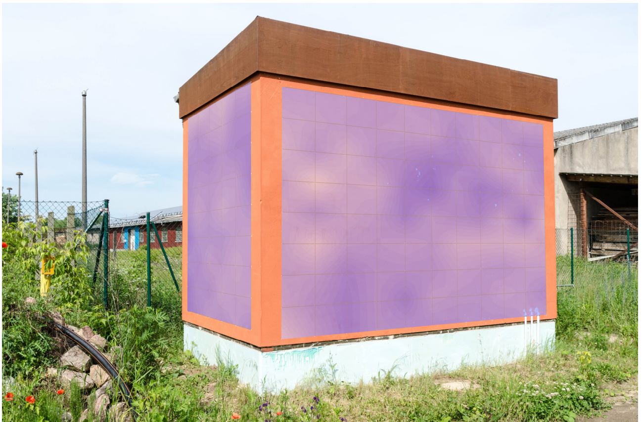
Versuchsgebäude 3 Ostseite, Mikrowellenmessung Messkopf PM 27.10.2017
