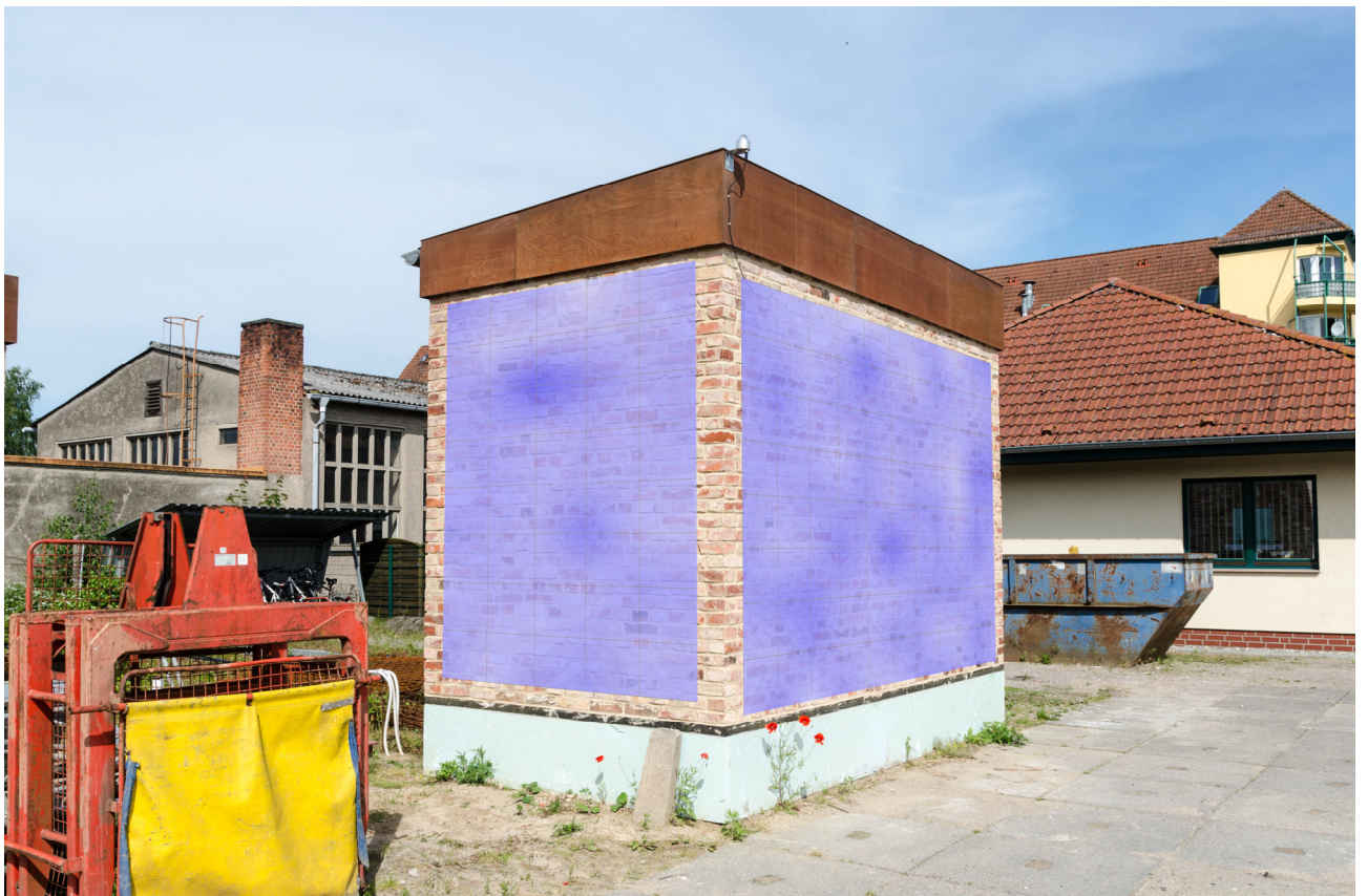
Versuchsgebäude 1 Ostseite, Mikrowellenmessung Messkopf PM 04.06.2017
