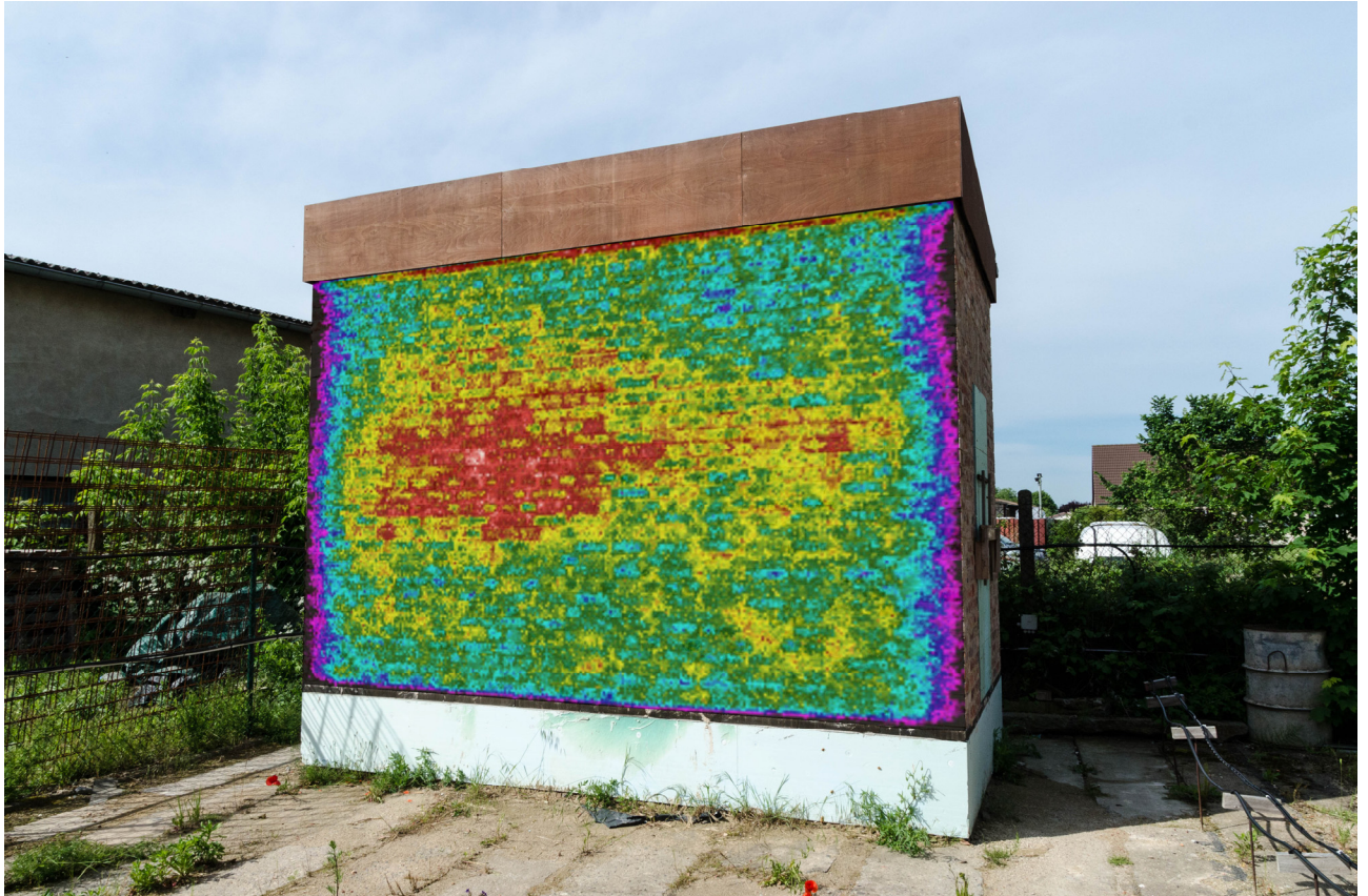
Versuchsgebäude 2 Ostseite, Thermografie 26.10.2017
