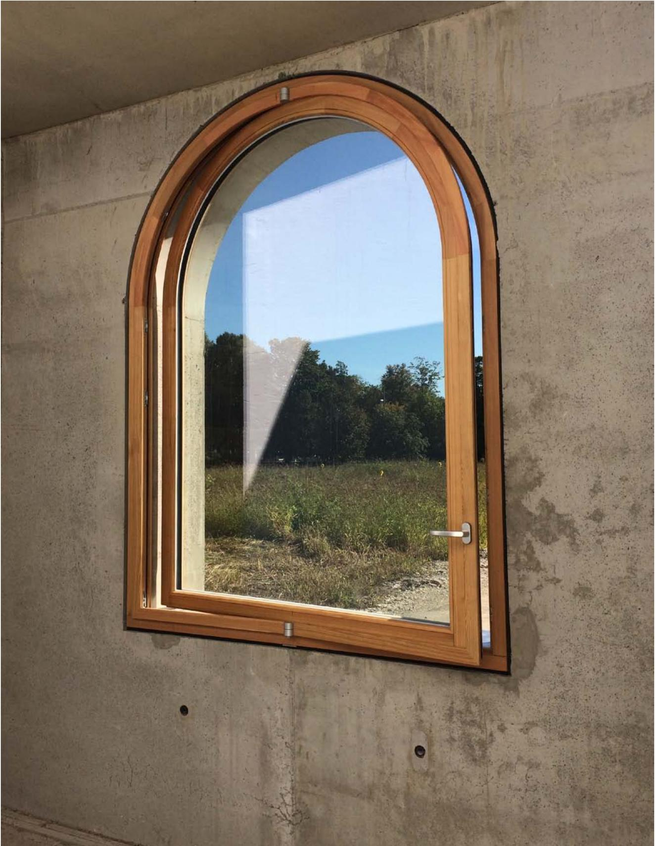
Infraleichtbeton: Lüftungsstellung Wendeflügel
