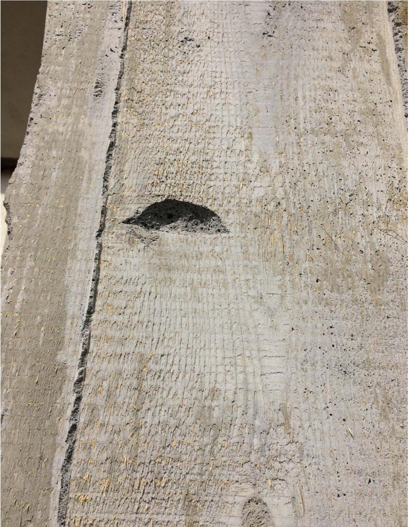
An Astlöchern in der sägerauhen Schalung kam es zu Ausbrüchen des Leichtbetons beim Ausschalen, vermutlich durch Verklebungen.
