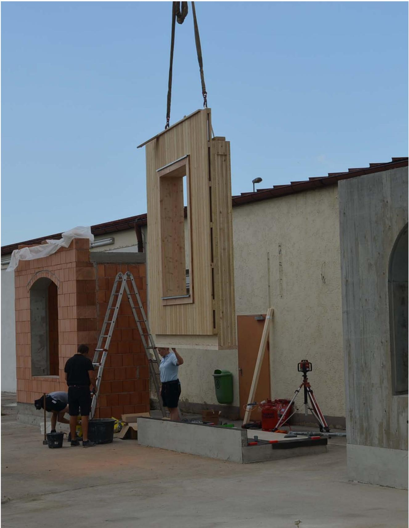
Montage der Außenwand aus Massivholz mit Außenverschalung
