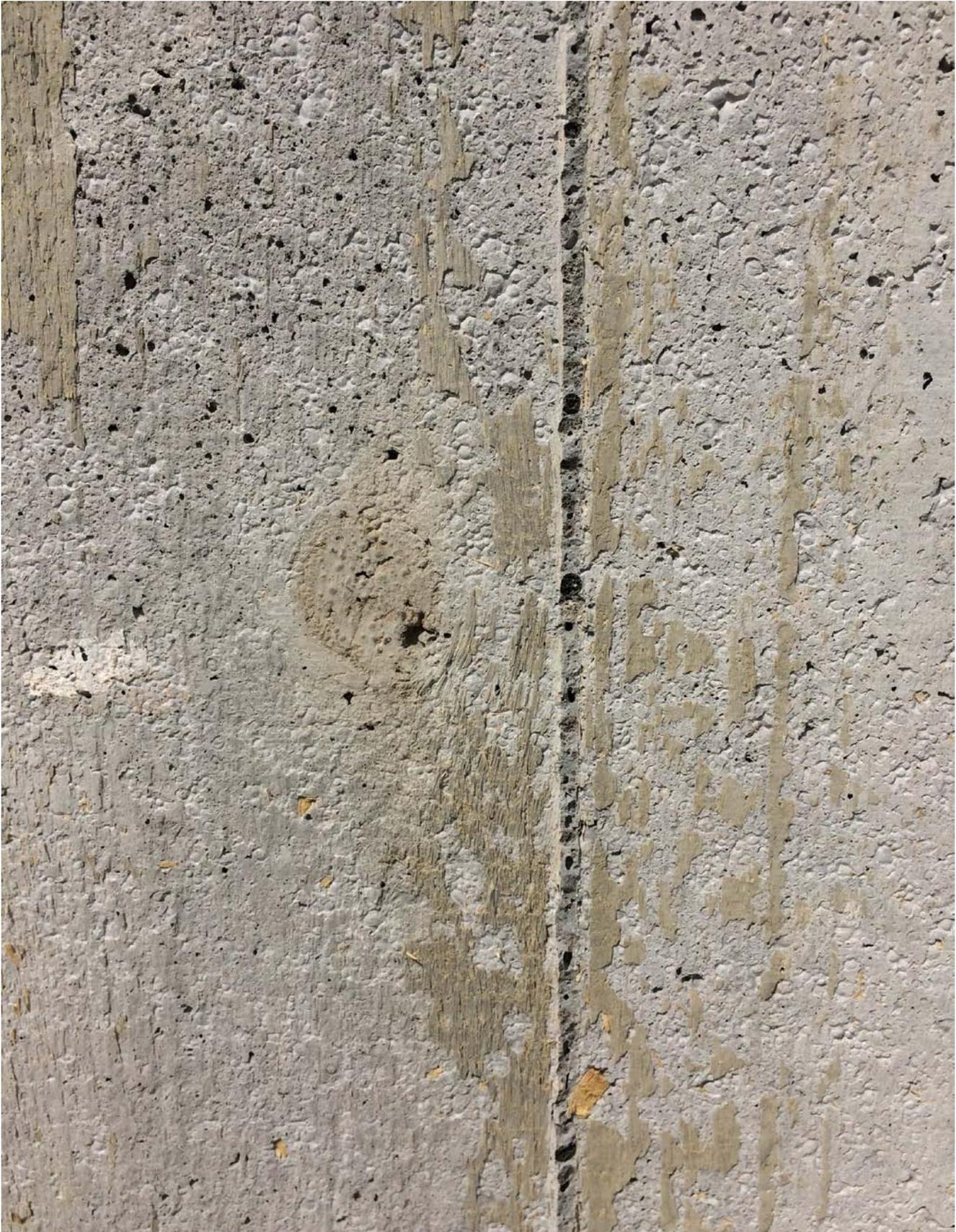
Die Zementschlämme auf den sägerauhen Brettern ist beim Ausschalen teilweise an der Betonoberfläche haften geblieben.
