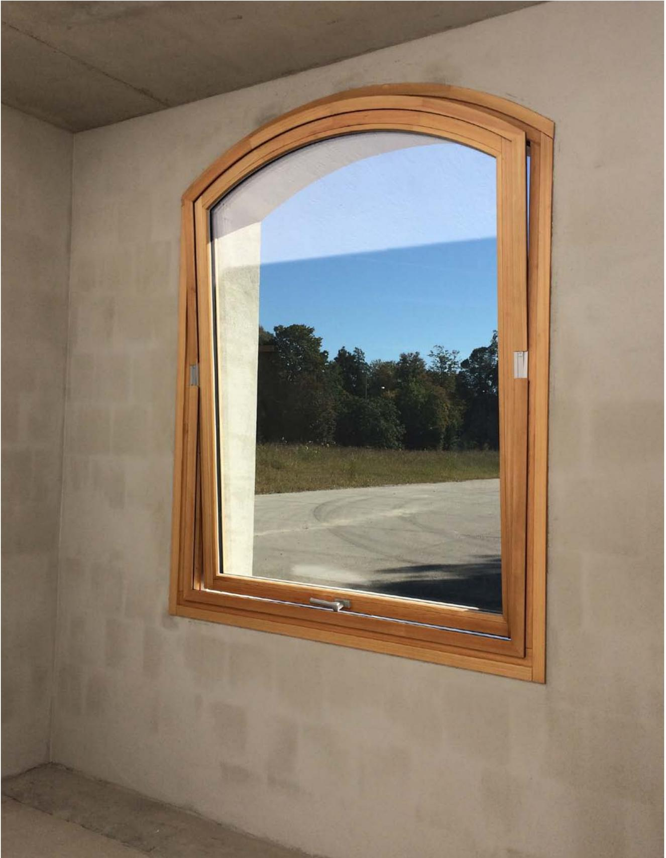
Mauerwerk: Lüftungsstellung Schwingflügel
