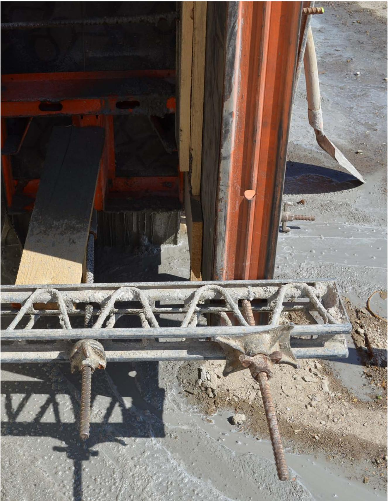
Im Bereich der Schalungsfugen trat während des Betoniervorgangs eine größere Menge Betonmilch aus
