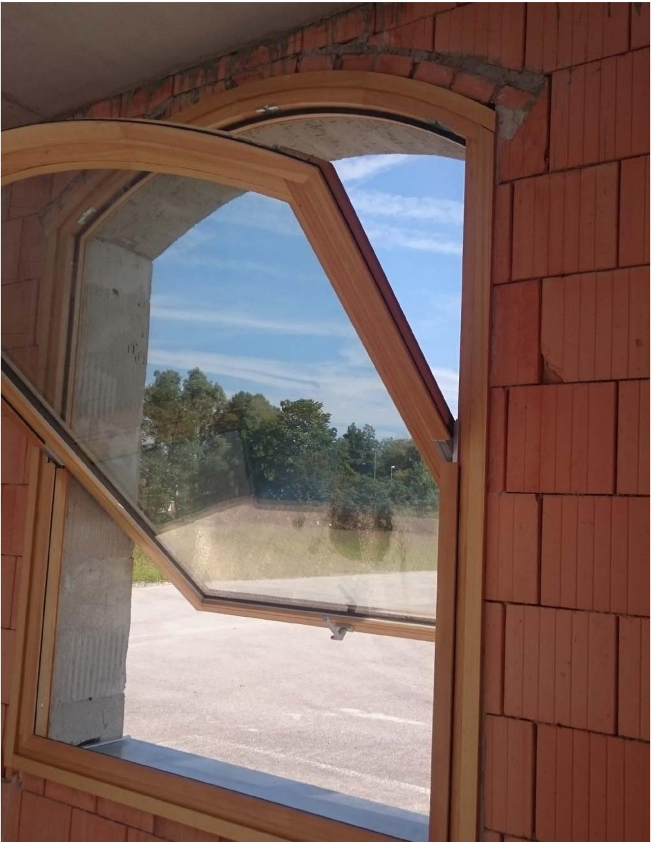
Fenster im Mauerwerk mit seitlicher Verleistung welche die Montagefuge überdeckt
