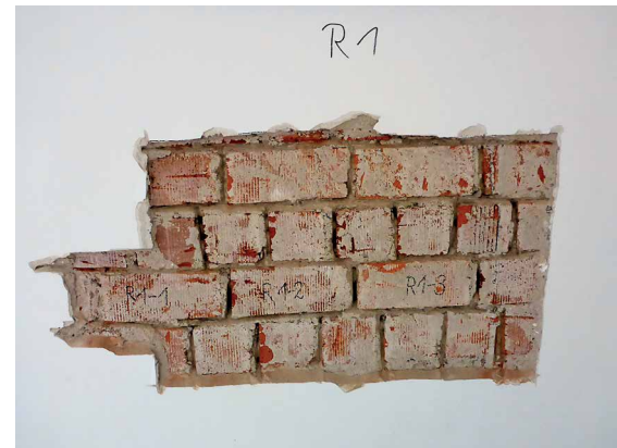
Abb. 1: Entnahmestelle Innenwand – kleinformatiges Ziegelmauerwerk (HLz 2DF)
