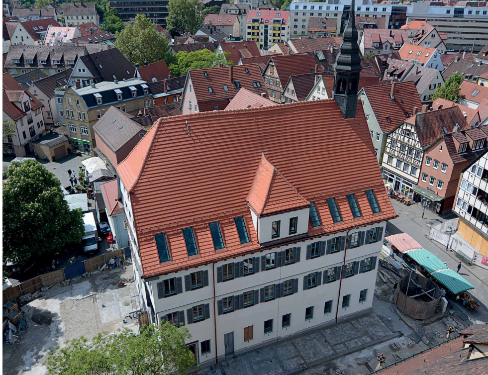
Abb. 1: Nach seiner umfassenden Sanierung ist das spätgotische Fachwerkgebäude wieder leistungsfähig und ästhetisch.
