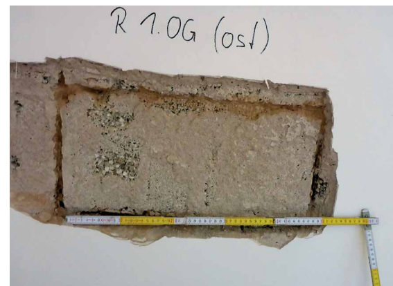
Abb. 2: Entnahmestelle Außenwand – großformatiges Hohlblocksteinmauerwerk aus Leichtbeton
