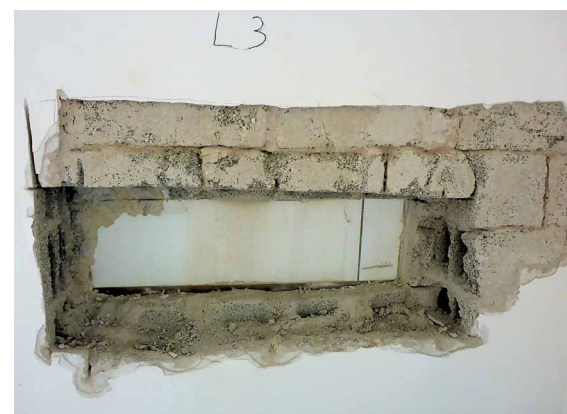
Abb. 3: Entnahme von großformatigen Mauersteinen (ca. 500 x 300 x 240 mm)
