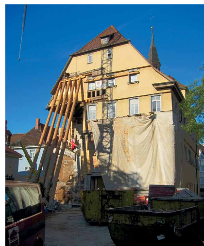
Abb. 4: Statisch aufwendig war das neue Treppenhaus inklusive Betonunterfangung über einer Doline. Hier war der Altbau um 80 cm abgesunken.
