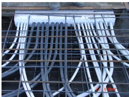
استفاده از پلاستفوم جهت محل قرارگیری لوله‌های انتظار سقف
