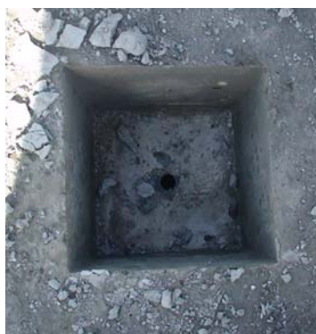
قالب فلزی محل عبور لوله‌ها از سقف بتنی
