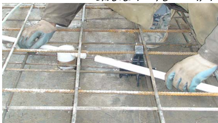
ترمیم شکستگی لوله‌ها در حین بتن ریزی
