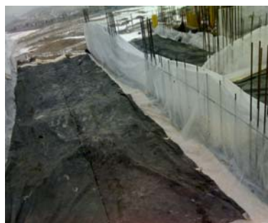
پوشش روی بتن توسط پشم شیشه و برزنت
