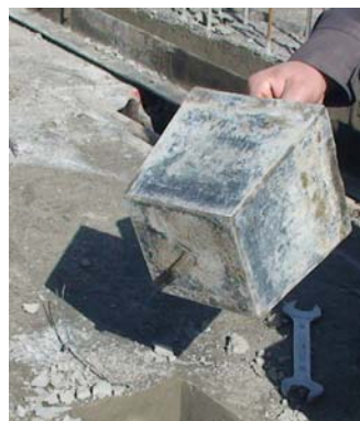
قالب فلزی محل عبور لوله‌ها از سقف بتنی
