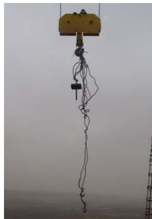
تجمیع سیم بکسل‌ها در قلاب تاور جهت جابجایی سریع قالب‌ها
