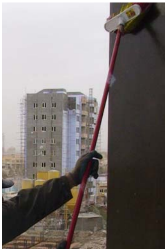
تمیزکاری و روغن کاری قالب‌ها در روی پلت فرم‌ها
