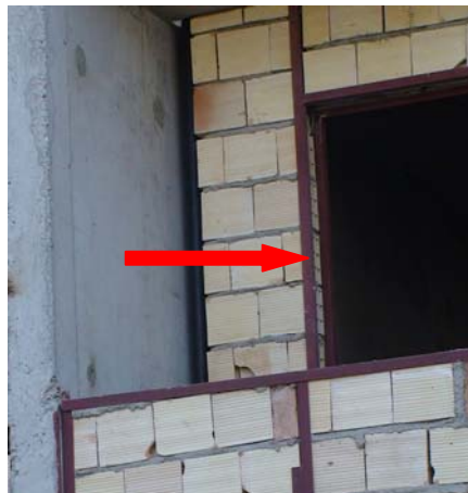
استفاده از غلاف جهت جلوگیری از تخریب دیوارها در هنگام لوله کشی
