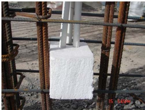
استفاده از پلا ستفوم جهت محل قرارگیری لوله‌های انتظار دیوار
