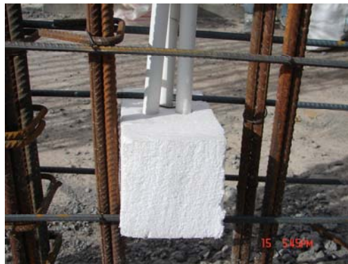
استفاده از پلاستفوم جهت محل قرارگیری لوله‌های انتظار دیوار
