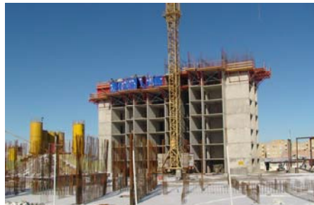
استتار قسمت خروجی قالب تونلی
