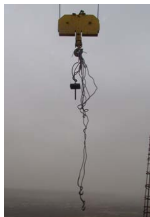
تجمع سیم بکسل‌ها در قلاب تاور جهت جابجایی سریع قالب‌ها
