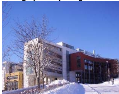
NTNU-Realfabygget(137 HVAC system)
