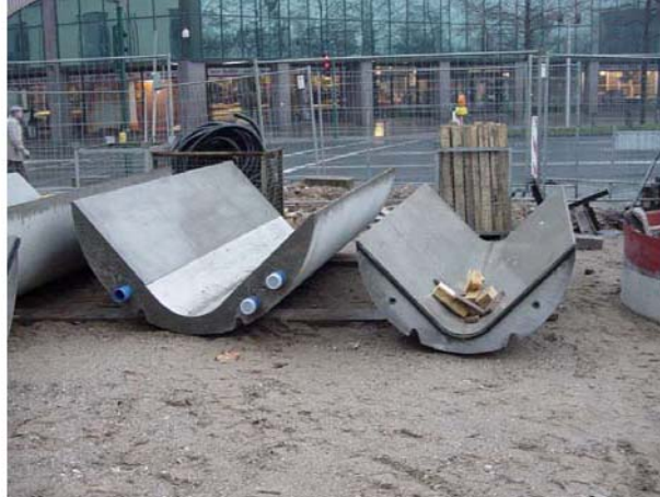
Trockenwetterrinnen Rabtherm Leverkusen (D) Dry weather channels.
