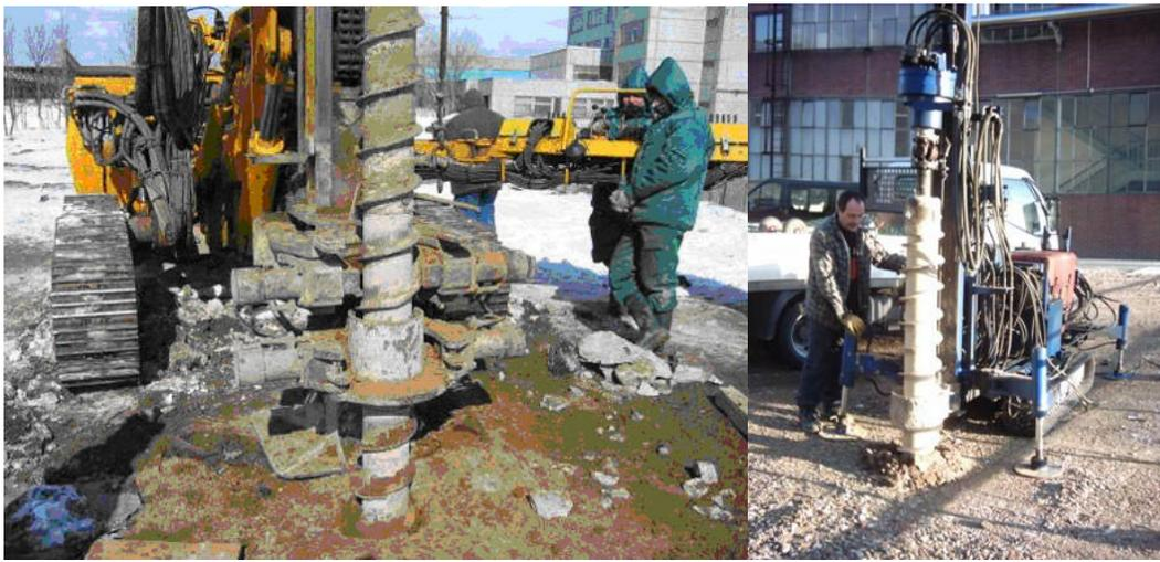
Abbildung 2.7: Hohlbohrschnecke (links: [25], rechts: [29])
