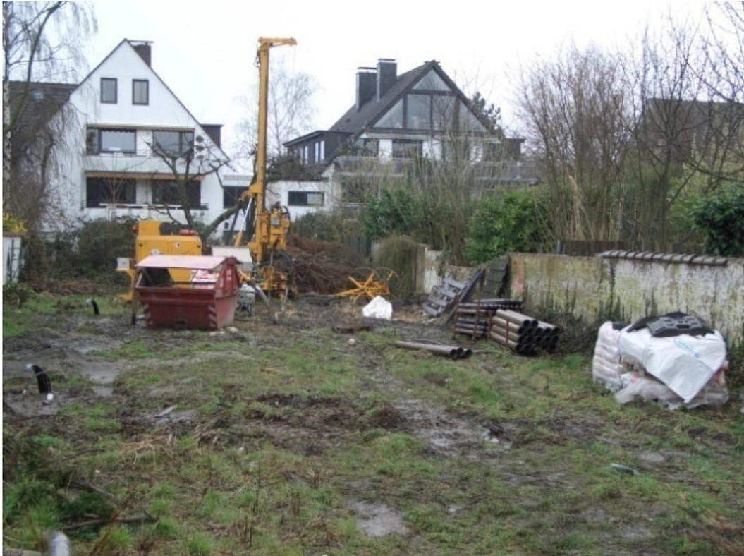
**Abbildung 7.7: Schwer zugängliche Bohrstelle durch aufgeweichten Untergrund**
