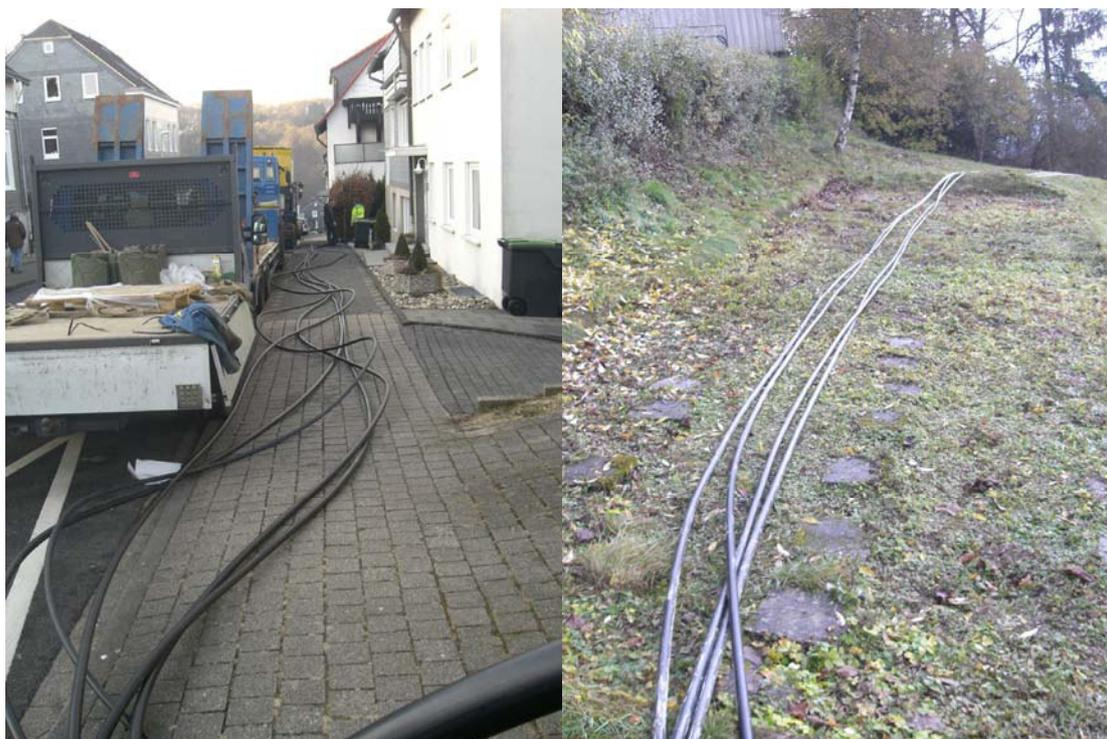
**Abbildung 7.26: Einbau von abgerollten Doppel-U-Sonden**
