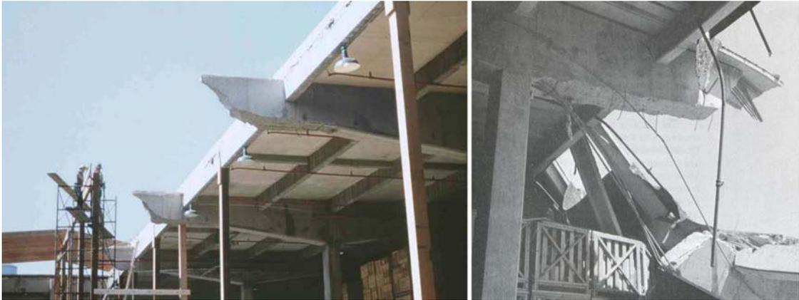
Abb. 4.1: Schubversagen der Dachbinder des Air Force Warehouses [108], [4]
