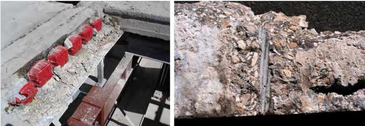
**Abb. 5.6.:** Auflagerbereich der Platten (links) und Bruchstück mit Verankerungslösung (rechts)
