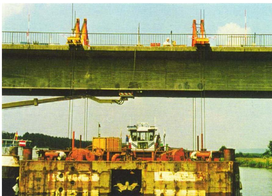
Abb. 3.7: Belastungsversuch einer Spannbetonbrücke in Baiersdorf [110]
