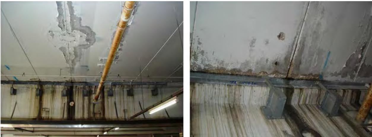
**Abb. 5.2.:** links: Ansicht der Deckenkonstruktion von unten, rechts: Stahlwinkel zur Verlängerung der Auflager
