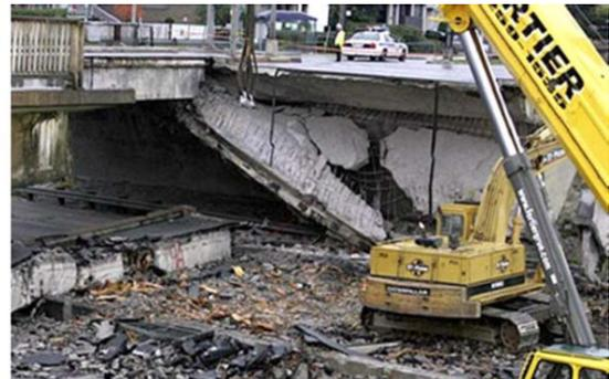
Abb. 4.2: Schubversagen des Concorde overpass 2006 [58]
