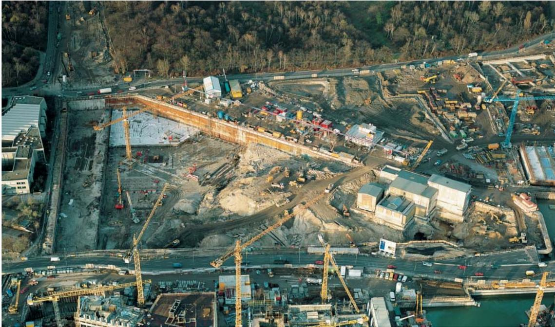
Abb. 2.1: SONY-Baugrube während der Aushub- und RI-Pfahlarbeiten.
