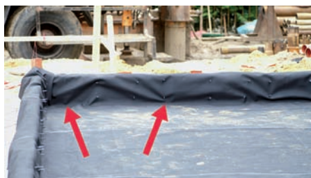
Abb. 05: Die Abdichtungsbahn ist an den Randaufkantung faltig, von zahllosen Kunststoffankern der Randdämmplatten perforiert und an der Außenecke als »Faltpaket« verlegt
