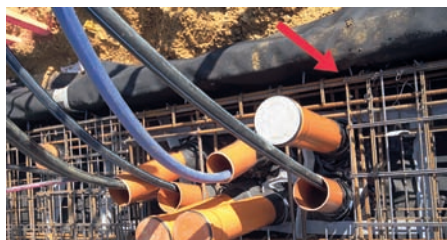
Abb. 07: Die Bewehrung der Bodenplatte wurden direkt auf der Abdichtungsbahn verlegt und stößt teilweise gegen die EPDM-Bahn an der Randaufkantung
