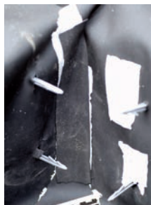
Abb. 05: Die Abdichtungsbahn ist an den Randaufkantung faltig, von zahllosen Kunststoffankern der Randdämmplatten perforiert und an der Außenecke als »Faltpaket« verlegt
