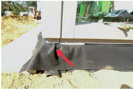
Abb. 10: Die lose verlegte Abdichtungsbahn wird bei der Montage der Wandelemente zwangsläufig verschoben und bildet Falten; punktförmige Belastung der Abdichtungsbahn durch die Auflagerplatten unter der Eckstiele der Außenwände
