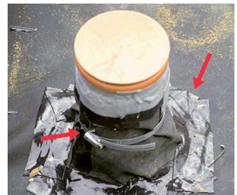
Abb. 4: Der Anschluss der Abwasserrohre an die Abdichtung erfolgte mittels Klebebändern, faltigen Reststücken der EPDM-Bahn und einer schmalen Schelle
