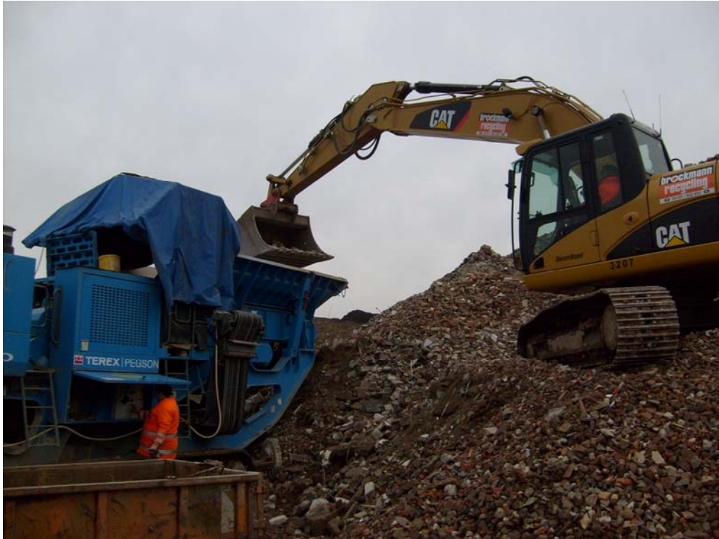
Bild N4: Beschickung des Backenbrechers, Brockmann Recycling GmbH, Nützen, Foto: TerraTextura GmbH, Soest
