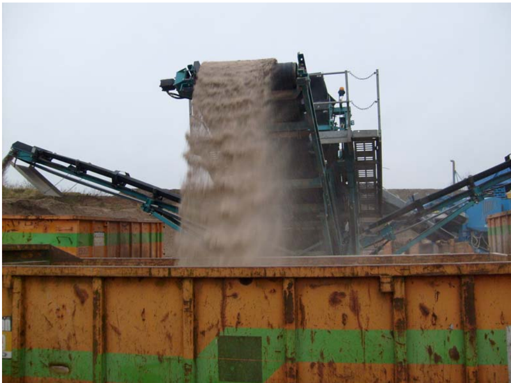
Bild N5: Befüllung der Mulde mit Kalksandsteinbruch, Brockmann Recycling GmbH, Nützen, Foto: TerraTextura GmbH, Soest
