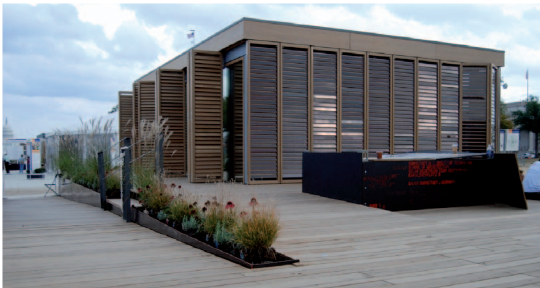
Abbildung 1: Nordwestecke des Gebäudes [Quelle: Leon Schmidt; TUD]
