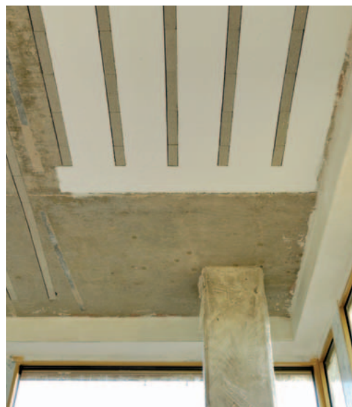
Abbildung 5: Detail der Geschossdecke mit eingeklebten Glasschaumstreifen
