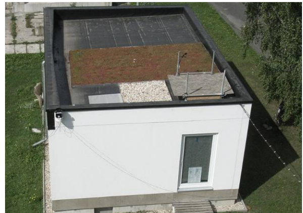
Abb. 9 Versuchsstand mit den untersuchten Deckschichten
