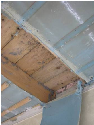
Schadensfreier Bereich (Westseite)
