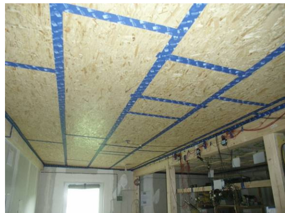
Abb. 11 raumseitig diffusionshemmende Schichten, OSB-Platte
