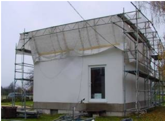
Abb. A - 4 Erstellung des Flachdachaufbaus
