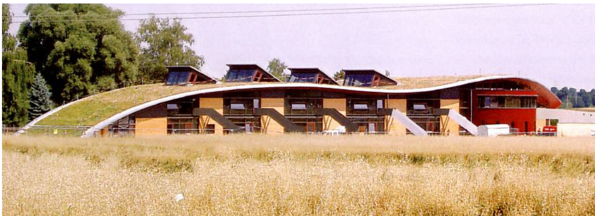
Abb. 1 Montessorischule Erding, Holzrahmenbau mit begrüntem einschaligen Flachdachaufbau
