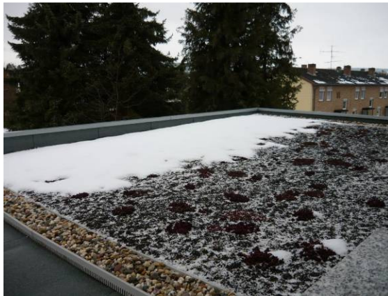
Draufsicht auf Büroanbau
