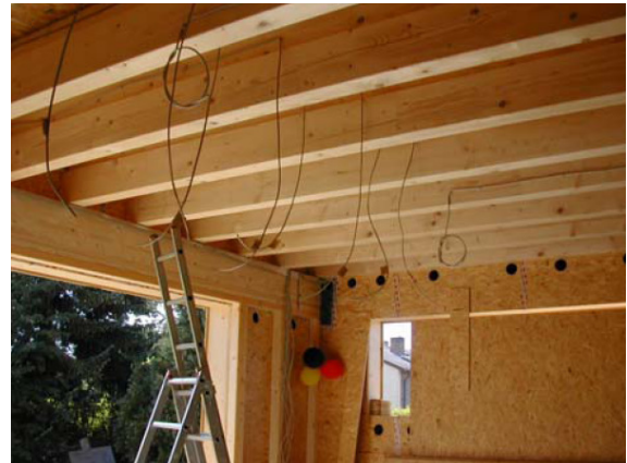
Ausbauzustand Innenseite mit Messtechnik
