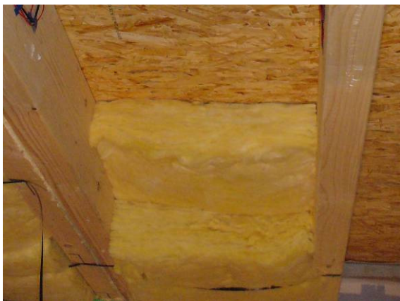
Abb. 10 Gefachbereich beim Einbringen des Dämmstoffes (Glaswolle)
