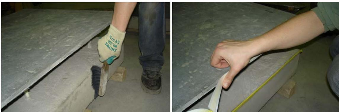
Abbildung 5.5: Anbringen des elastischen, beidseitigen Klebebandes am Fassadensystem
