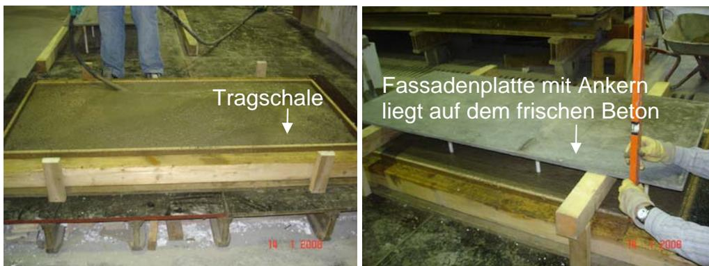
Abbildung 5.4: Fassadenplatte mit Ankern liegt auf dem frischen Beton
