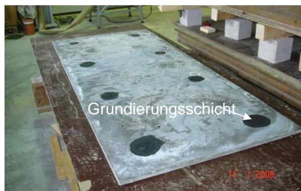
Abbildung 5.2: Anwendung der Grundierungsschicht auf der Fassadenplatte
