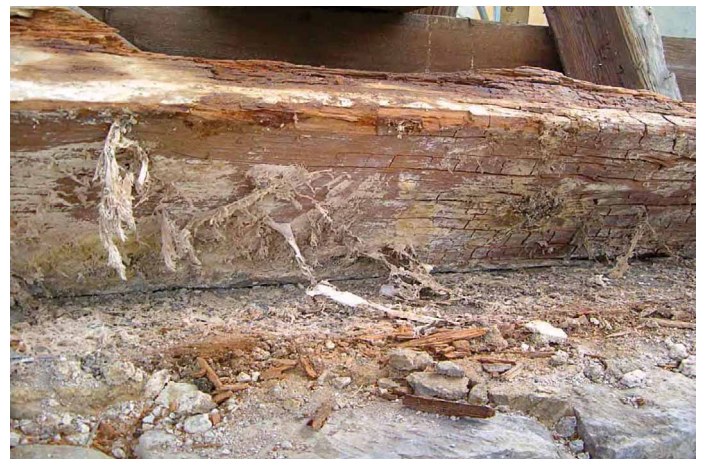
Hausschwambefall mit typischem Würfelbruch (rechts im Bild)
