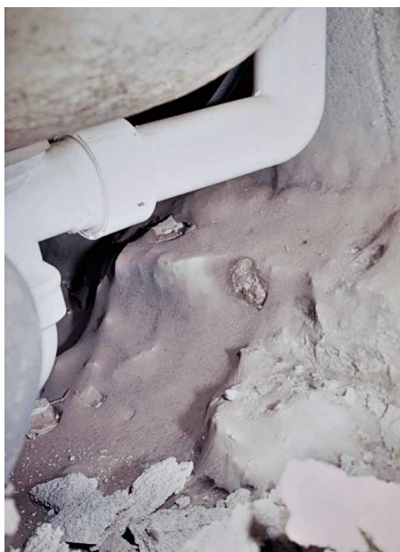
Spinnwebartiges Hausschwamm-Myzel
