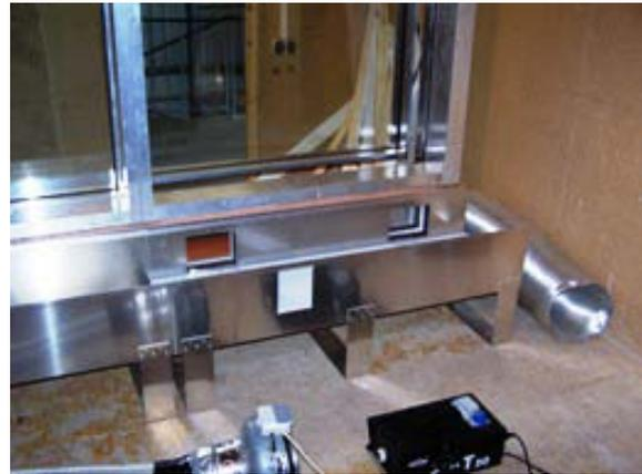
**Abbildung 25** Einbau der Wanne für Unterflurgerät (rechts)
