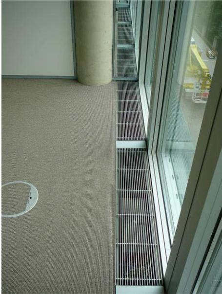
**Abbildung 167** Unterflurlüftungsgerät – Foto: TROX GmbH (links)
