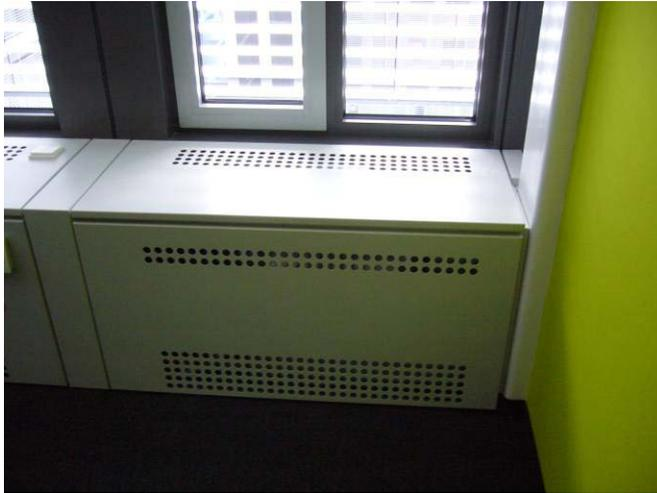
**Abbildung 165** dezentrales Brüstungsgerät – Foto: TROX GmbH (links)
