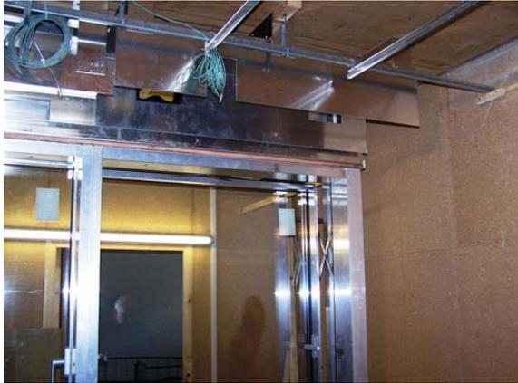
**Abbildung 24** Einbau der Wanne für Deckengerät (links)
