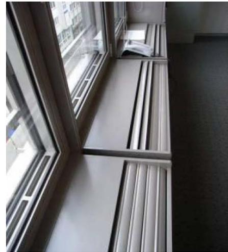
**Abbildung 166** dezentrales Lüftungselement installiert auf einer Brüstung (rechts)
