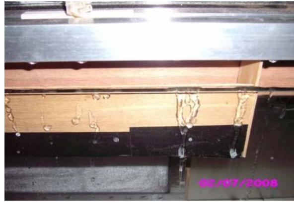
**Abbildung 88 Vereisung an der Fassade im Heizfall**
