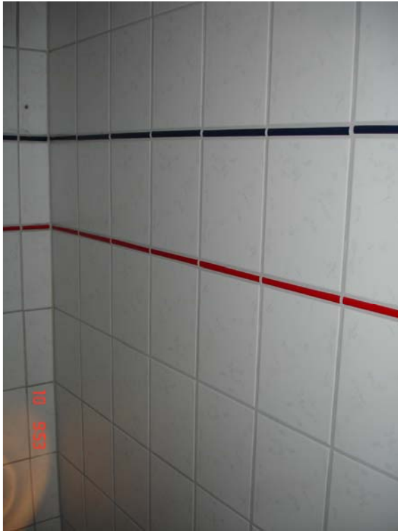
Abbildung 62: Badfliesen in einer realen Baumaßnahme vor der Demontage
