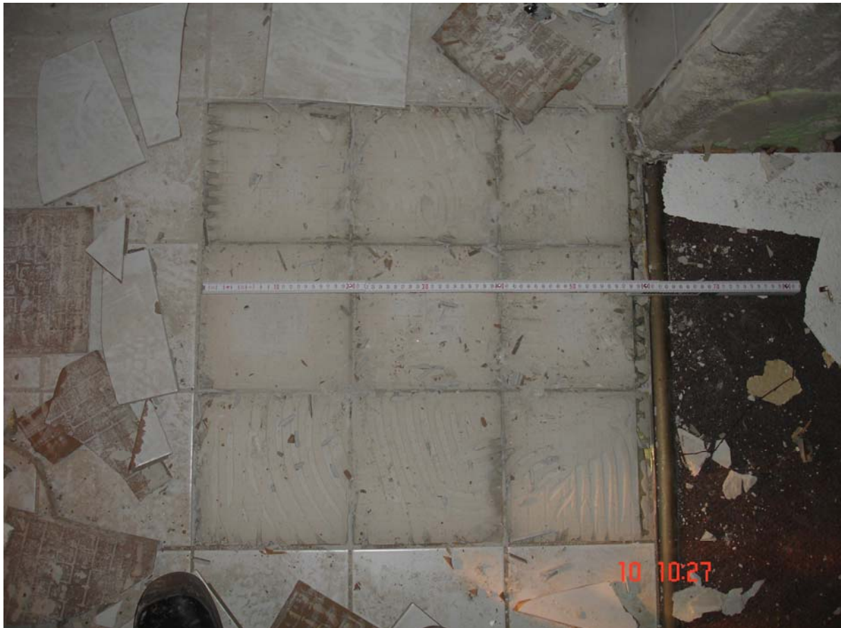
Abbildung 66: Ablösen von Bodenfliesen in einer realen Baumaßnahme
