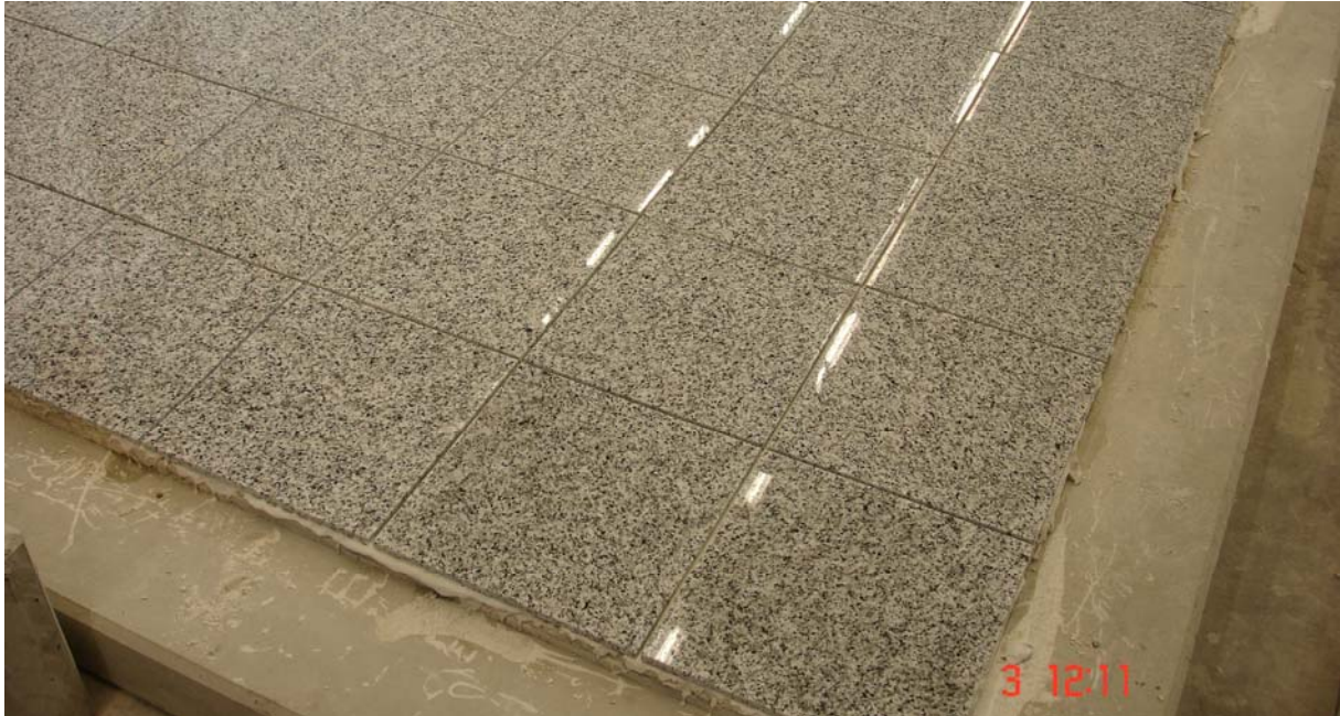
Abbildung 10: Natursteinbelag auf Zementestrich vor dem Verfugen
