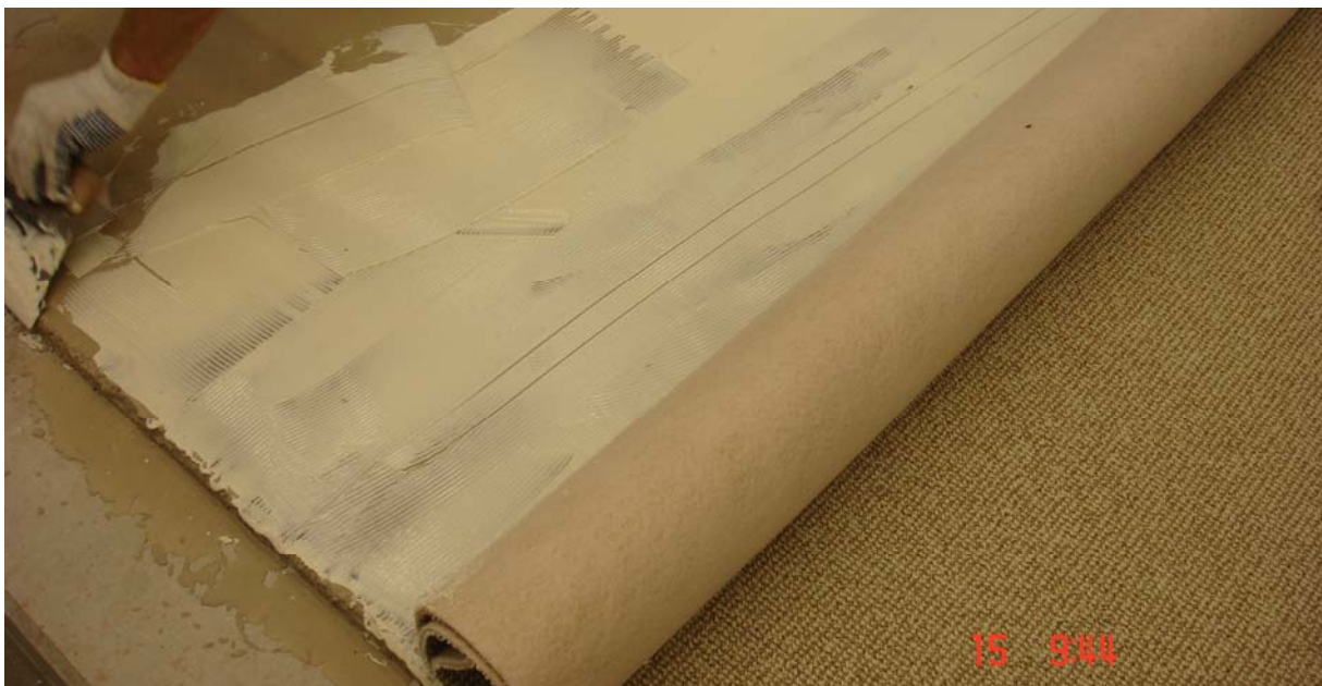
Abbildung 11: Teppichboden auf Zementestrich während des vollflächigen Verklebens
