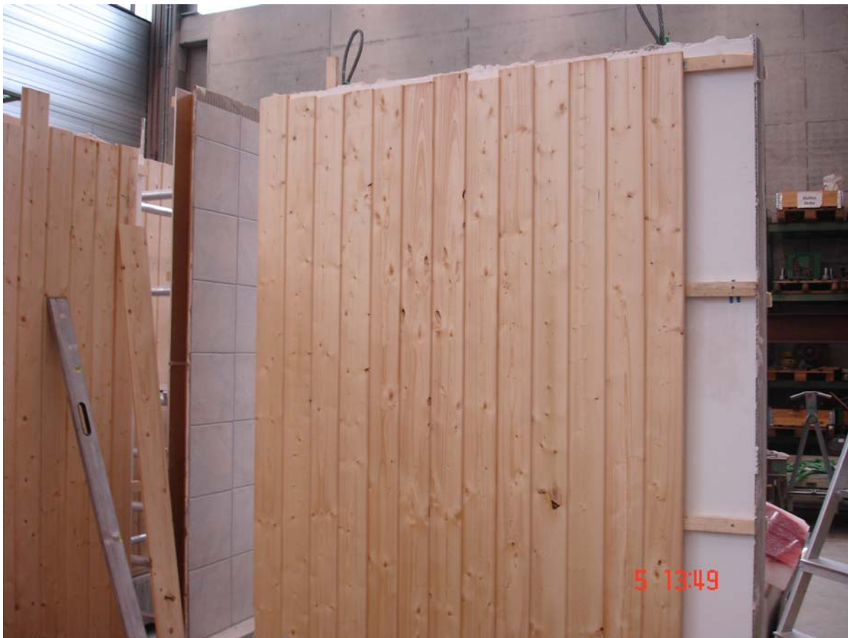
Abbildung 28: Wandbekleidung mit Unterkonstruktion
