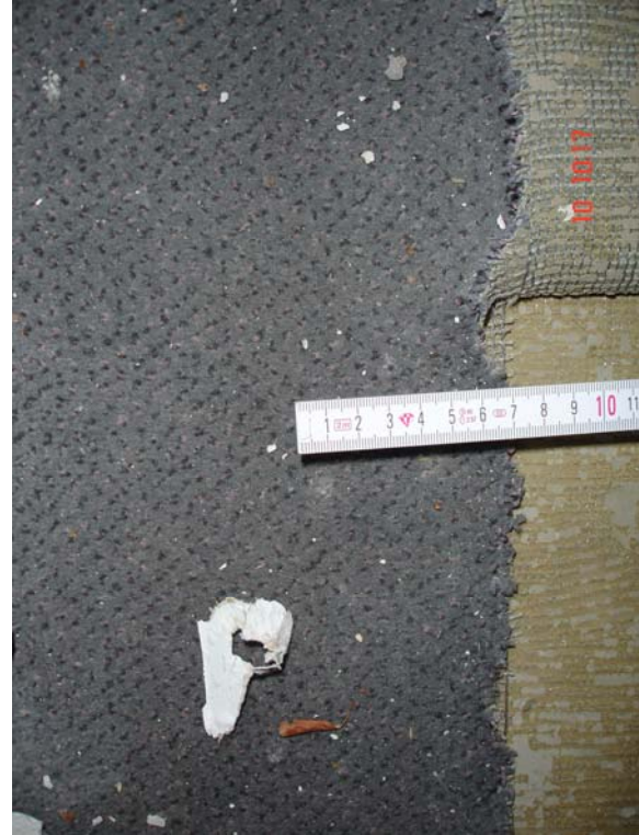
Abbildung 65: Abrissbereich des Teppichbodens bei der Demontage
