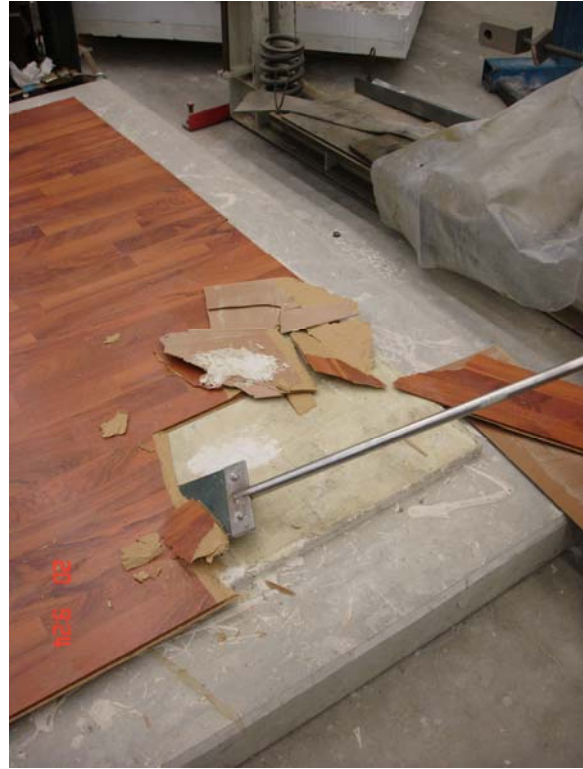
Abbildung 31: Händische Demontage des Laminatbodenbelags
