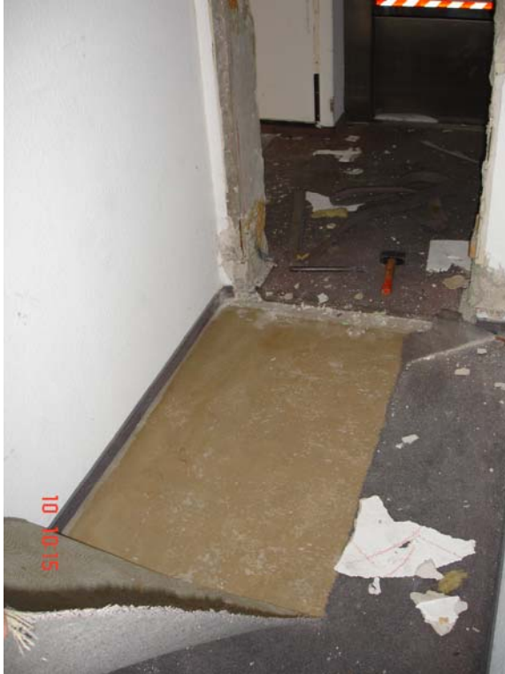
Abbildung 64: Teppichboden in einer realen Baumaßnahme bei der Demontage
