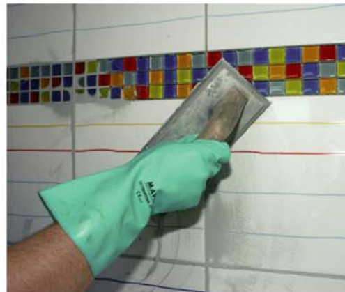
Komfortables, temperaturunabhängiges Verarbeitungsprofil – PCI Nanofug lässt sich geschmeidig leicht in die Fuge einarbeiten.
