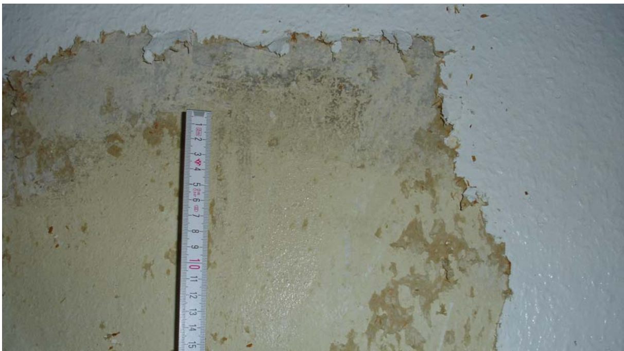
Abbildung 60: Ablösen von überstrichener Raufasertapete auf Zementputz in einer realen Baumaßnahme
