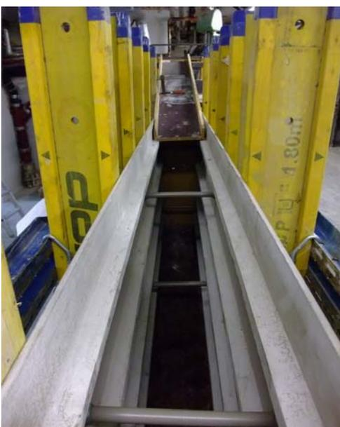
Bild 39: Seitliches Aufstellen der Schalung für die Wände 3 und 4
