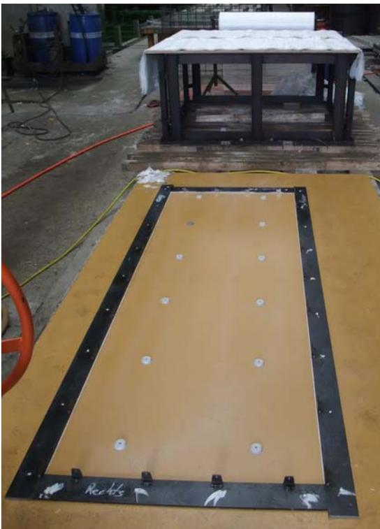
**Bild 19:** Schalung eines BIS-Elemente
