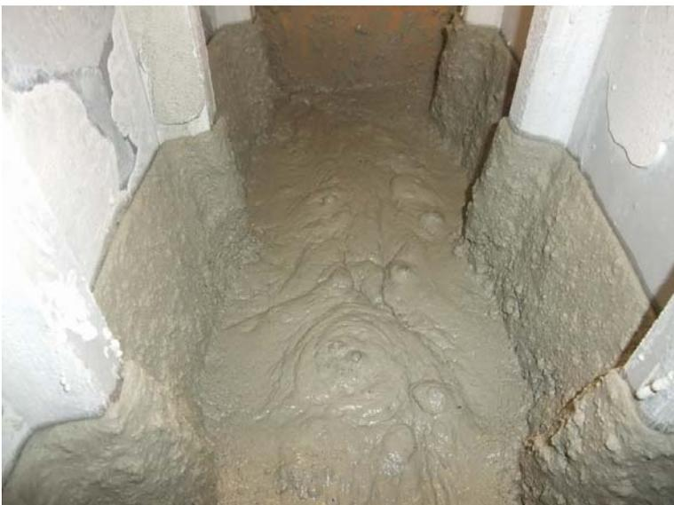
**Bild 38:** Entlüften und Absacken des SVPLB bei der Herstellung von Wand 1
