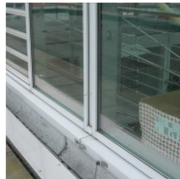
Druckmesspunkt (Bohrung im Profil)
