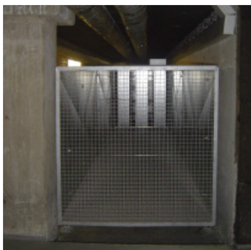
Abbildung 56 links: Austrittsöffnung mech. Lüfter; rechts: Volumenstrom
