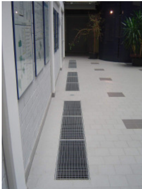
Abbildung 55 links: Bodenauslässe im KG; rechts: Planradiatoren im 1.OG
