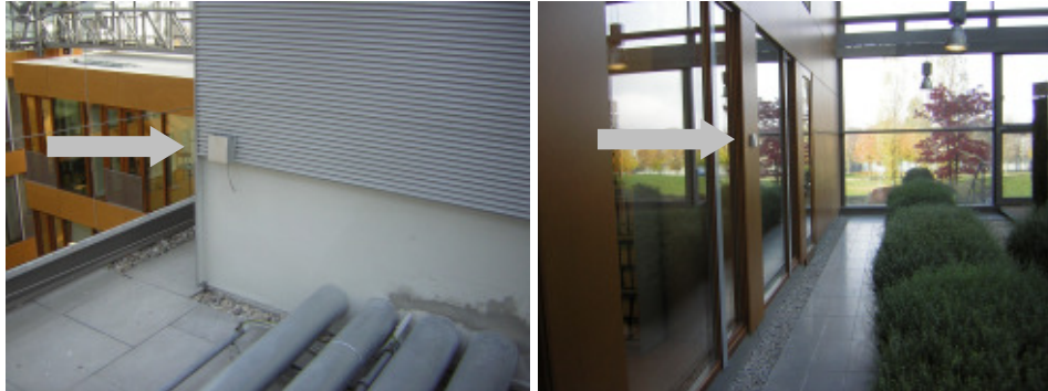
Abbildung 92 Temperatursensoren zur Messung der der Temperaturen im Grünhof D-E
