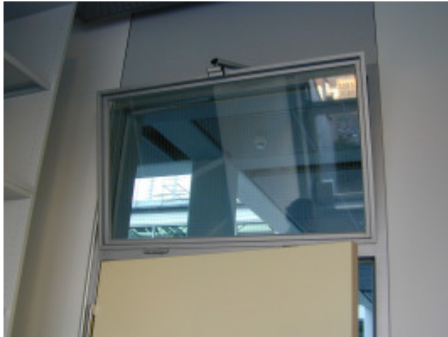
Abbildung 58 Türoberlicht zum Atrium und Raumbedienpaneel
