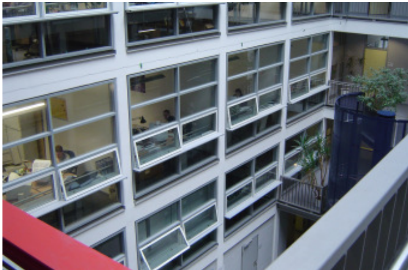
Abbildung 60 Fensterlüftungsflügel der innenliegenden Büros zum Atrium
