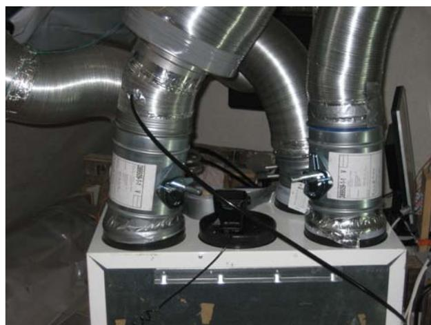
**Abb.32: Absperrklappen der Lüftungsanlage**
