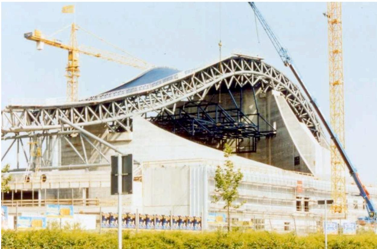
Abbildung 66: Stahlbetonbau mit aufgelegtem Stahlträger [59]
