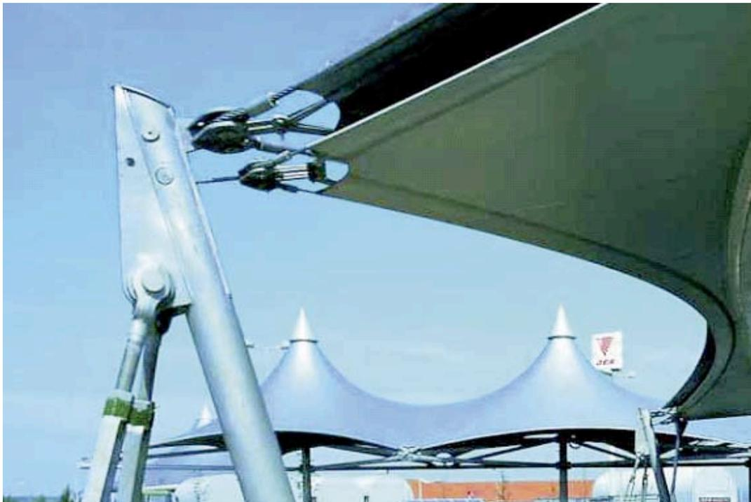
Abbildung 80: Befestigung an der Stütze [69]
