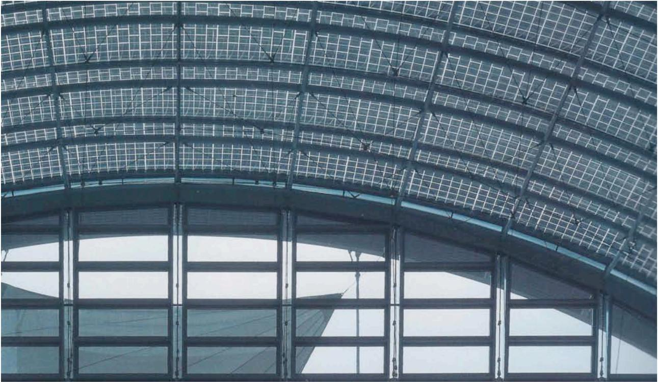
Abbildung 99: Bedruckte Folienkissen mit Unterspannung und Fassadenanschluss [117]
