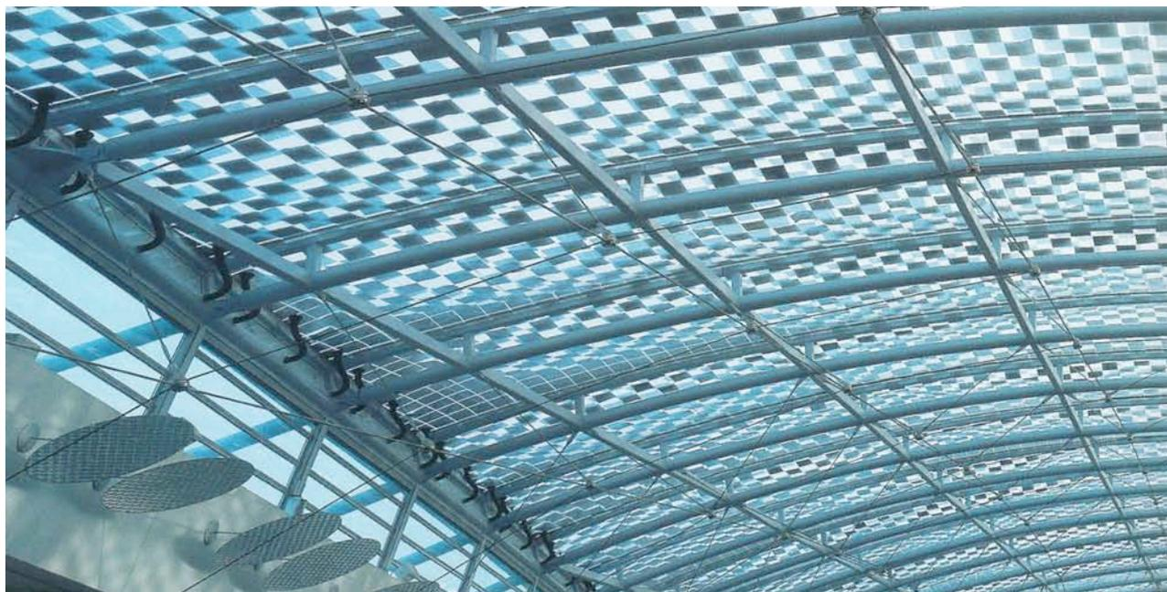
Abbildung 101: Untersicht: Sonnenschutz und Lichtlenkung [117]
