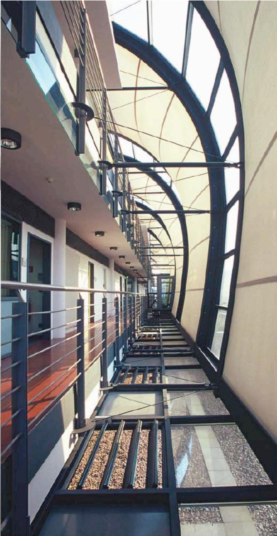
Abbildung 106: Erschließungsgang und regelbare Lüftungskappen [119]
