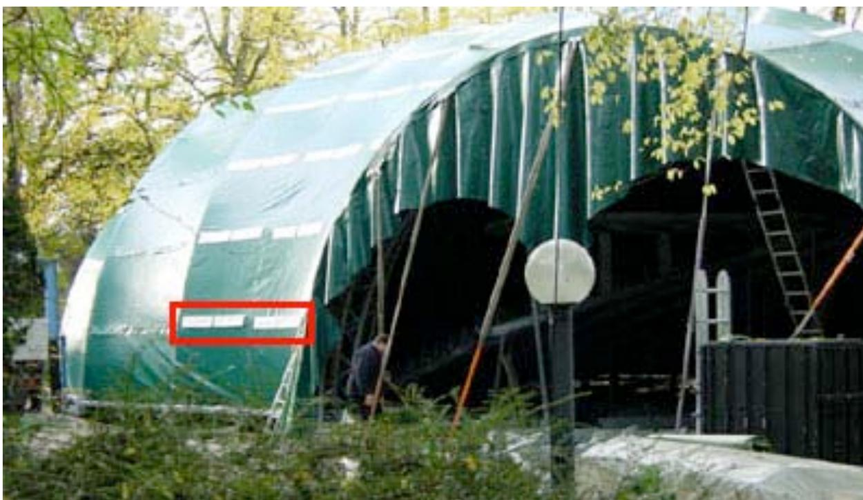
Abbildung 120: Während der Montage der Innenmembran [129]
