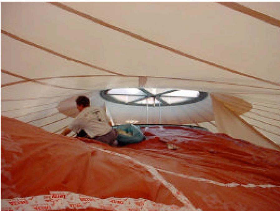
Abbildung 114: Montage der dampfdiffusionsoffenen Deckbahn [127]
