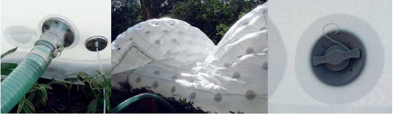
Abbildung 143: Luftzufuhr, Entfaltung und Abdichtung des Pneus [148]
