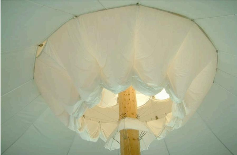
Abbildung 86: Innenansicht der Raffmembrane in ausgefaltetem Zustand [71]
