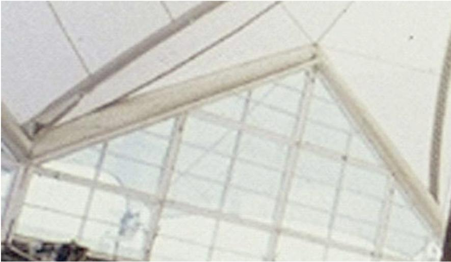
Abbildung 33: Randdetail mit Luftkissen zwischen Außenmembran und Fassade [18]
