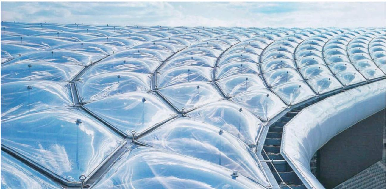
Abbildung 123: Dachaufsicht auf transparente ETFE-Folienkissen [142]
