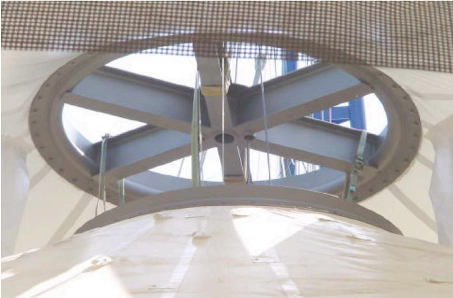
Abbildung 113: Hochpunkt und Membran mit Laschen zur Befestigung der Dämmung [127]
