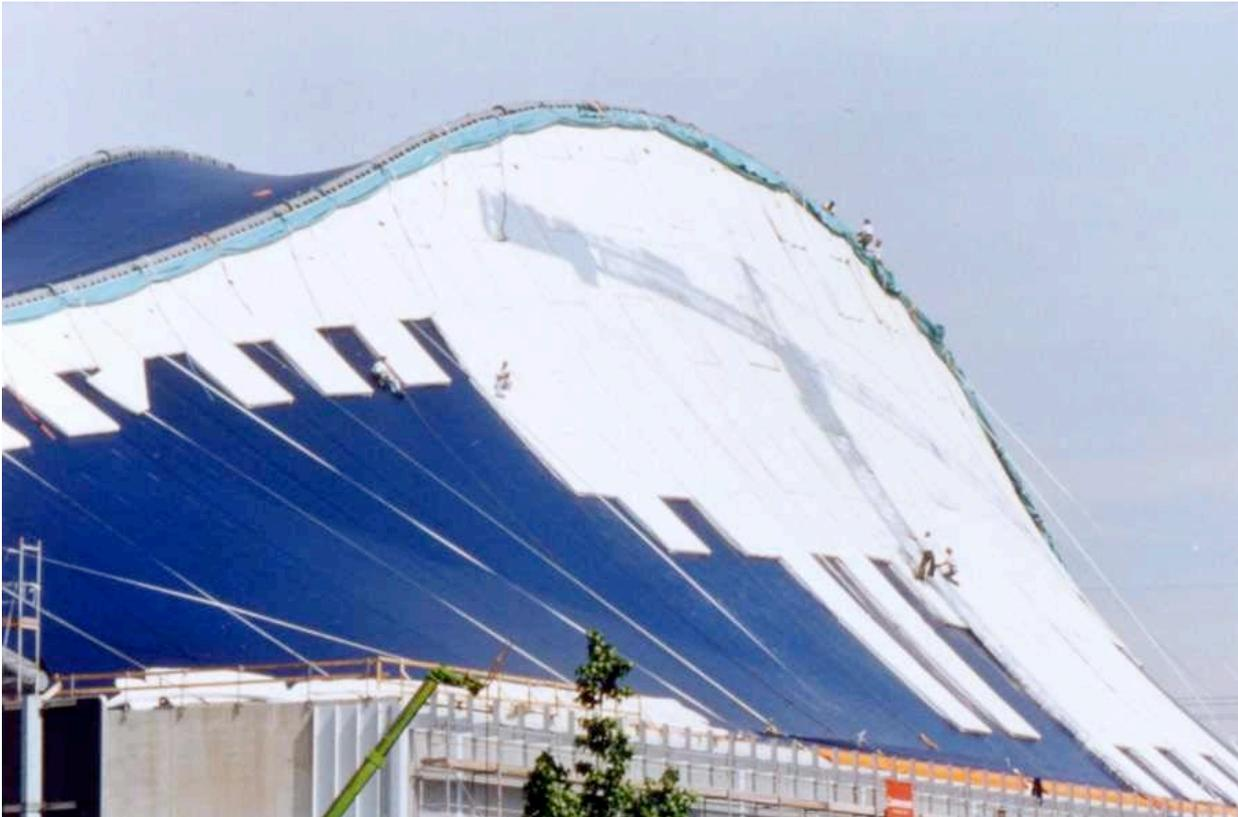
Abbildung 67: Die Montage der Dämmung [59]
