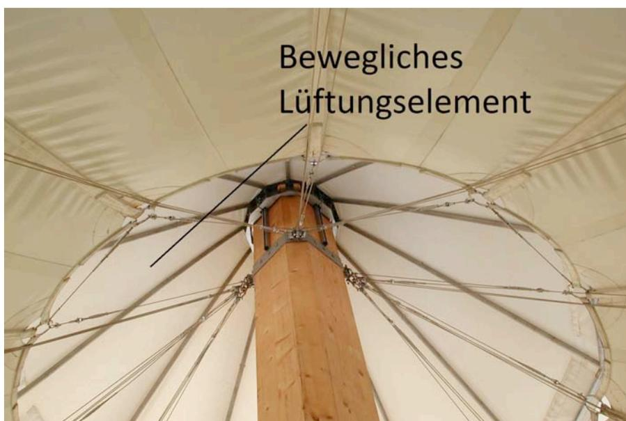
Abbildung 85: Innenansicht des Hochpunktes und des beweglichen Lüftungselementes [71]
