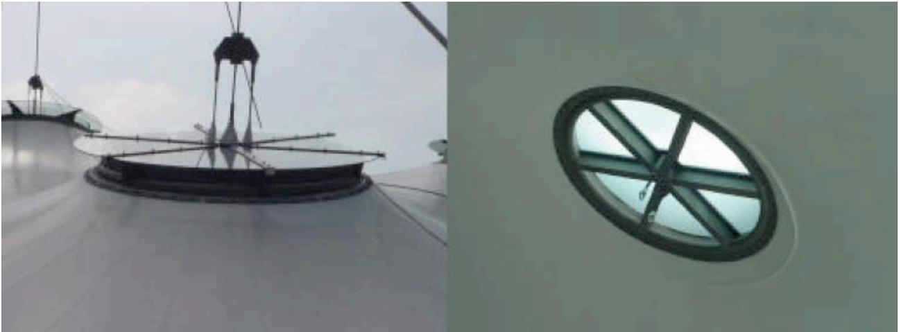
Abbildung 115: Fertiggestellter Hochpunkt. Außen- und Innenansicht [127]
