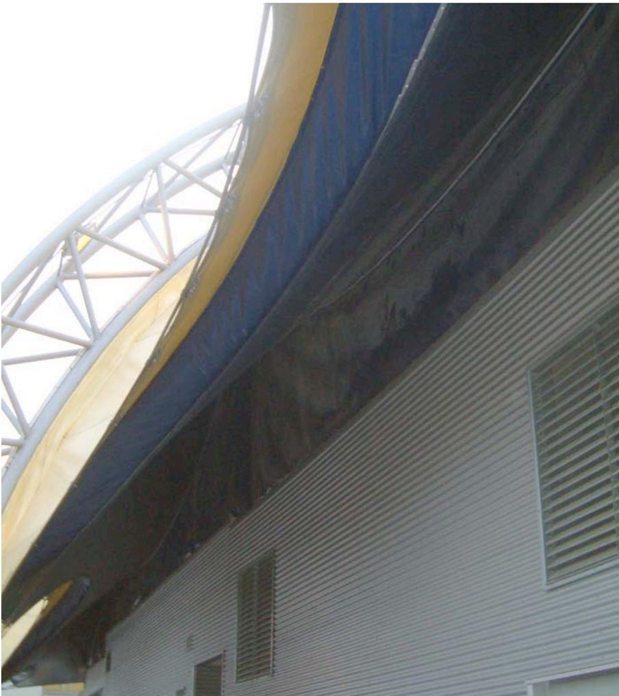
Abbildung 46: Untersicht des Dachüberstands mit seitlicher "Membranwand" [33]
