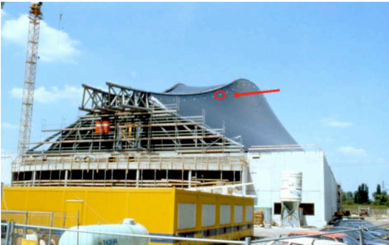
Abbildung 68: Außenansicht mit rot markierten Entlüftungsschläuchen [59]
