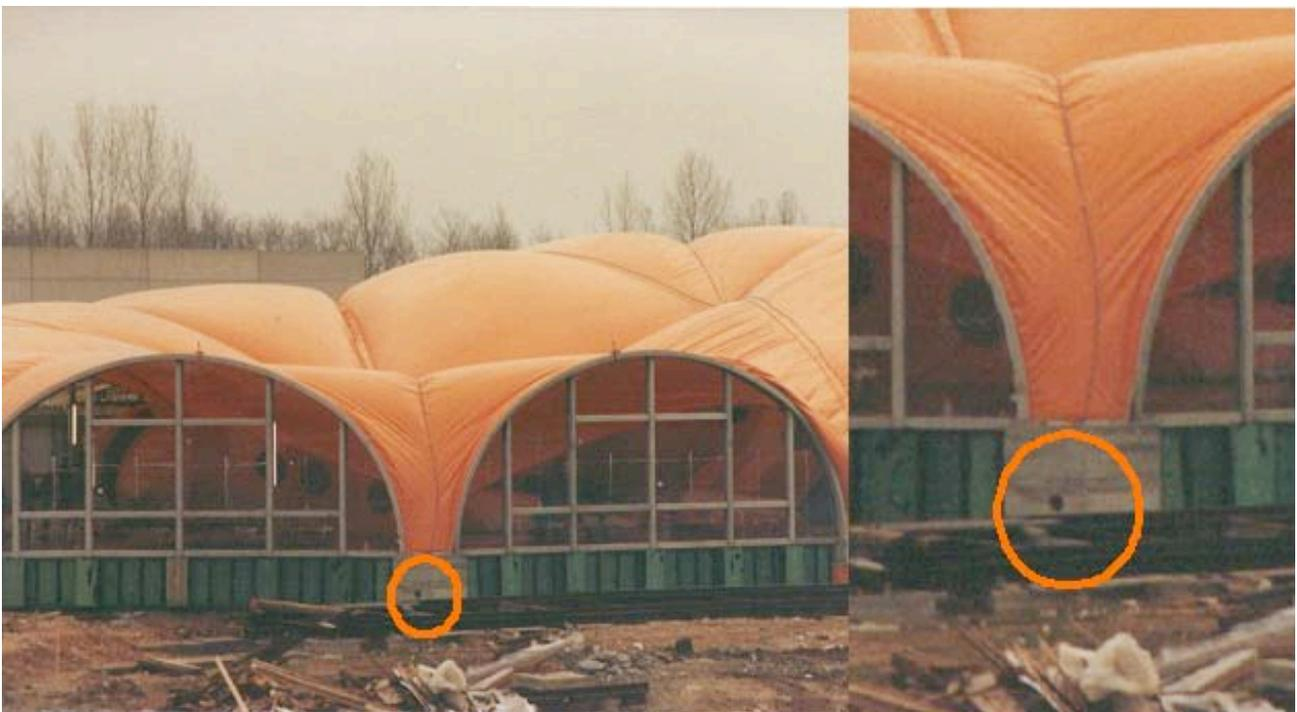
Abbildung 14: Kleines Gebläse zur Entfeuchtung des Membranzwischenraums [13]
