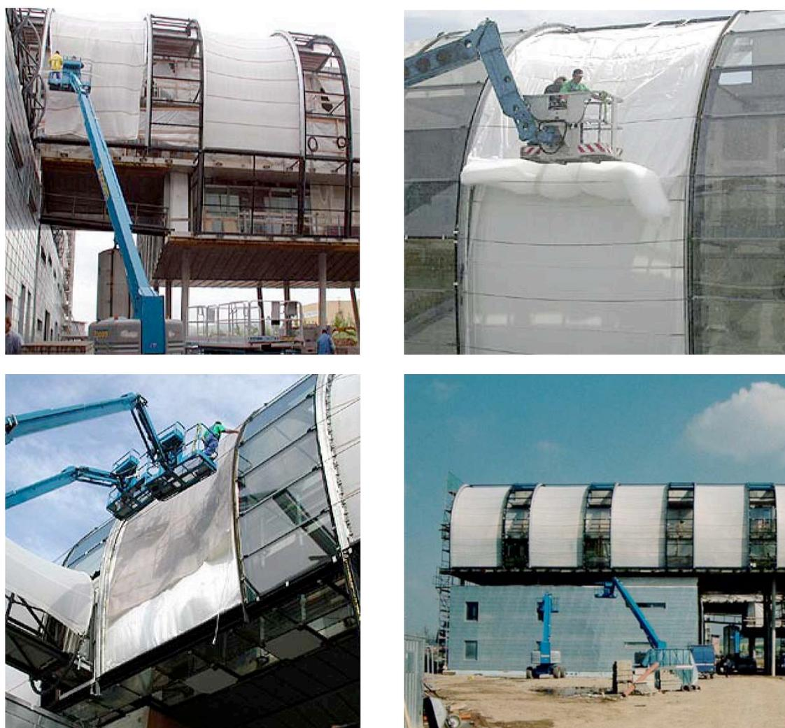
Abbildung 105: Befestigen der Dämmung [119]
