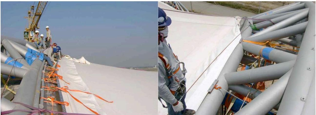
Abbildung 136: Während der Montage der Außenmembran [143]
