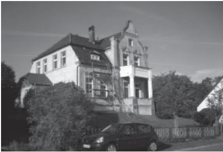
Foto 24: ehem. Kapitänshaus in Altwarp
