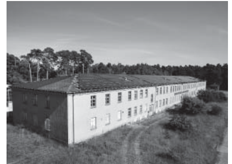
Foto 41: Solaranlagen auf den Häusern der alten Kaserne
