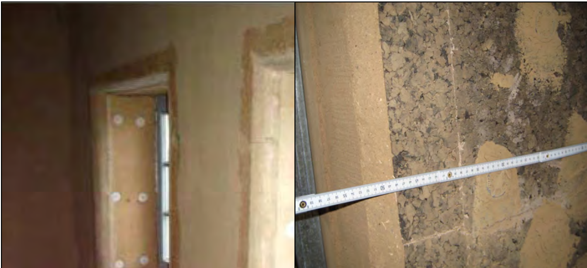
Abb. 40 + 41: Einbau der Holzweichfaser- bzw. Korkdämmplatten mit Dübeln
