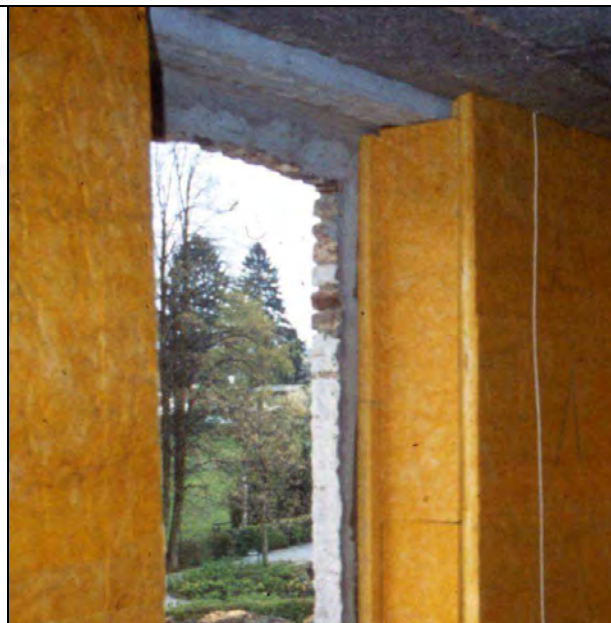
Abb. 28: ausgeführtes Beispiel einer Innendämmung im Bereich der Fensterleibung bis hinter den Blendrahmen
