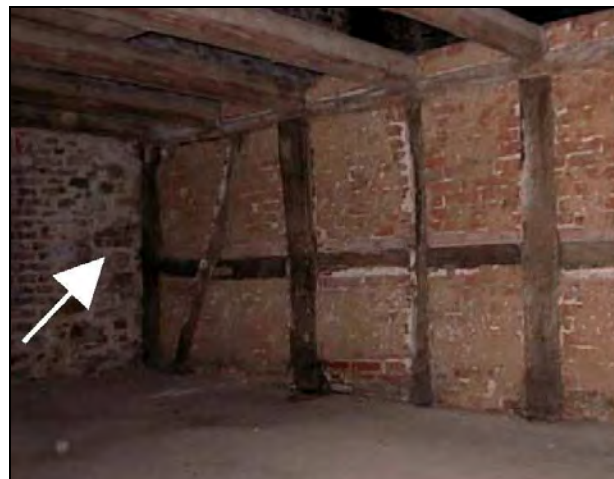
Abb. 66: Typisches Beispiel einer einbindenden Fachwerkwand
