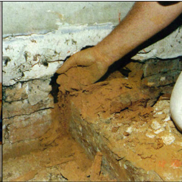
Abb. 72: Überprüfung des Zustandes der Balkenköpfe im Bereich der Auflager der Holzbalkendecke [Flohr 2009]
