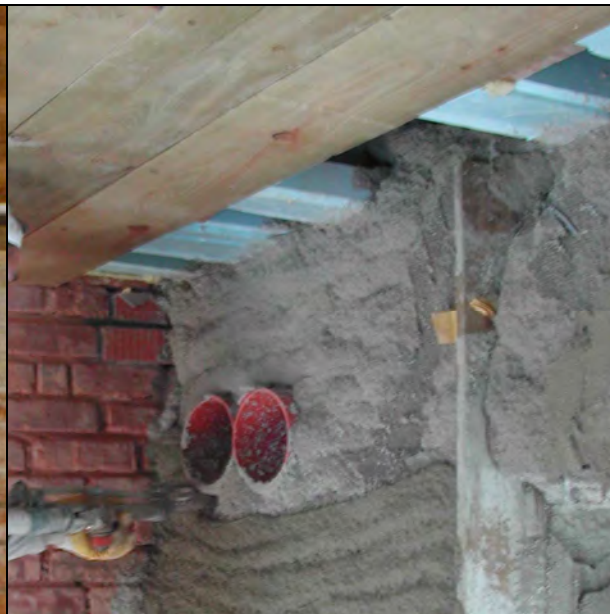
Abb. 74: Stahlträger gedämmt, Montage des Dämmputzes [Borsch-Laaks]
