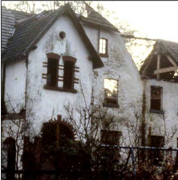
Abb. 4: Unsaniertem Zustand des Gutshofes im Jahr 1986
