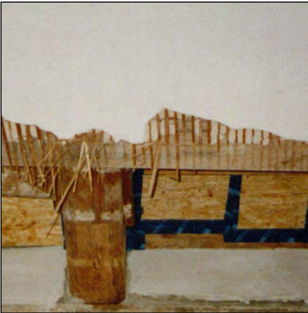
Abb. 71: Balkenköpfe der Holzbalkendecke ungeschädigt und tragfähig [Borsch-Laaks]
