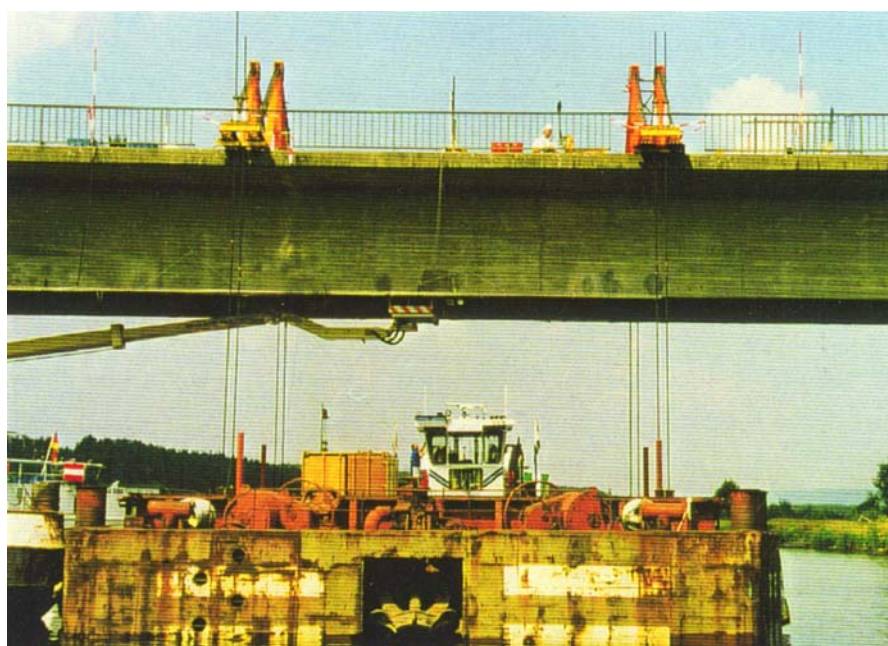
Abb. 3.7: Belastungsversuch einer Spannbetonbrücke in Baiersdorf [110]
