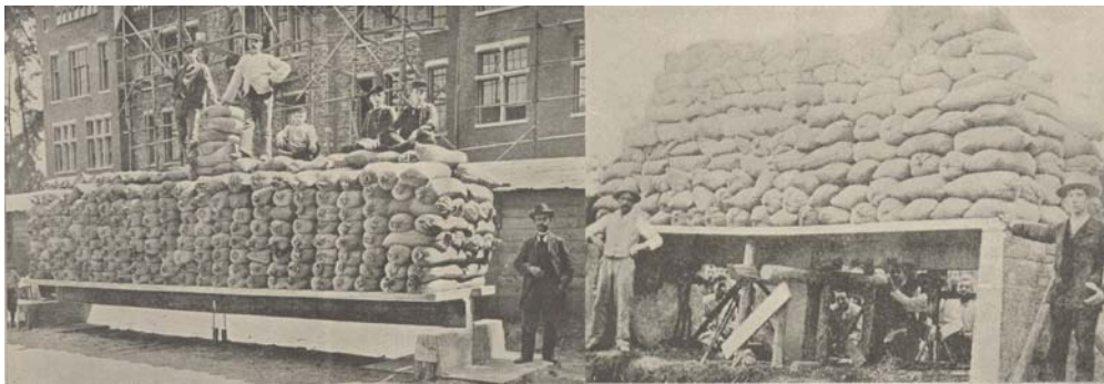
Abb. 3.5: Belastungsversuche für Werbezwecke [36]
