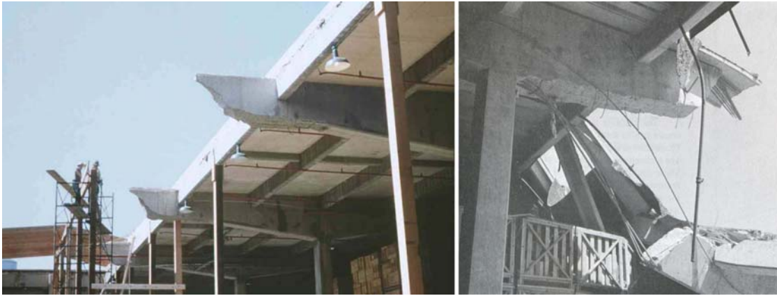
Abb. 4.1: Schubversagen der Dachbinder des Air Force Warehouses [108], [4]
