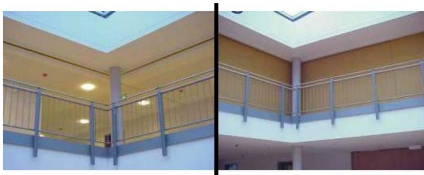
Abbildung 2.8: Geöffnete und geschlossene Rauchschürzen [Roda, 2011]
