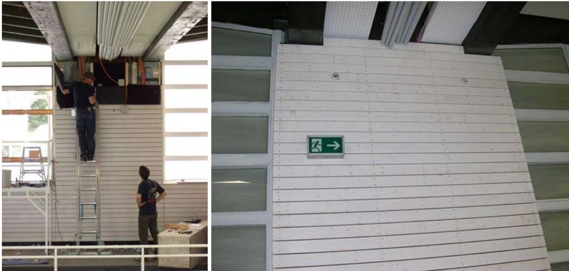
Abbildung 20: Kameras unterhalb der Auflager der Hauptträger, während (links) und nach Abschluss der Montagearbeiten (rechts)
