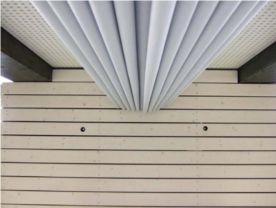
Abbildung 22: LEDs zweier Referenzpunkte hinter Verschalung im Bereich der nördlichen Auflager
