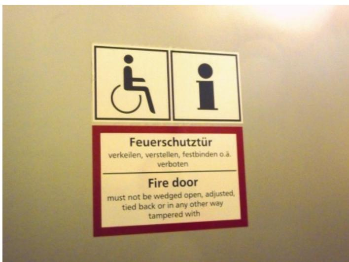
**Bild A5-23: Kennzeichnung des Vorraums am Feuerwehraufzug mittels Rollstuhlpiktogramm [Foto: Michels]**
