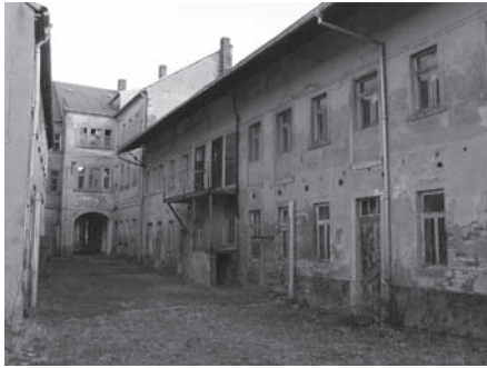
Foto 43: Alte Brauerei Rochlitz, Haus C
