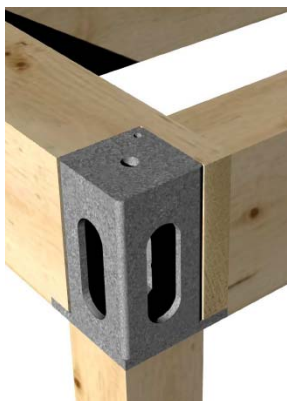
Abbildung 70: Fotorealistische Darstellung eines Knotens aus Stahl zur konsequenten Vermeidung von Querdruckspannungen \sigma_{c,90} ; Quelle: induo
