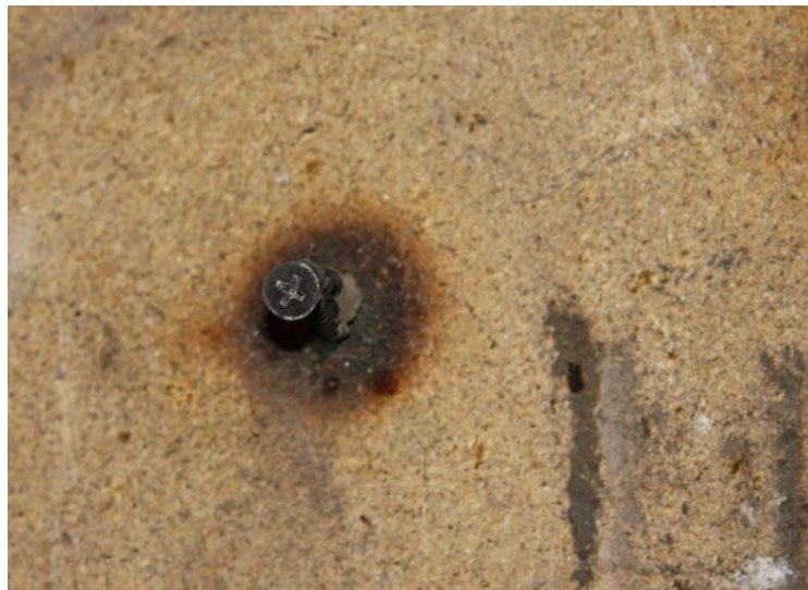
Abbildung 46: Verkohlung im Bereich der Schraube auf einer B1-Indikatorplatte
