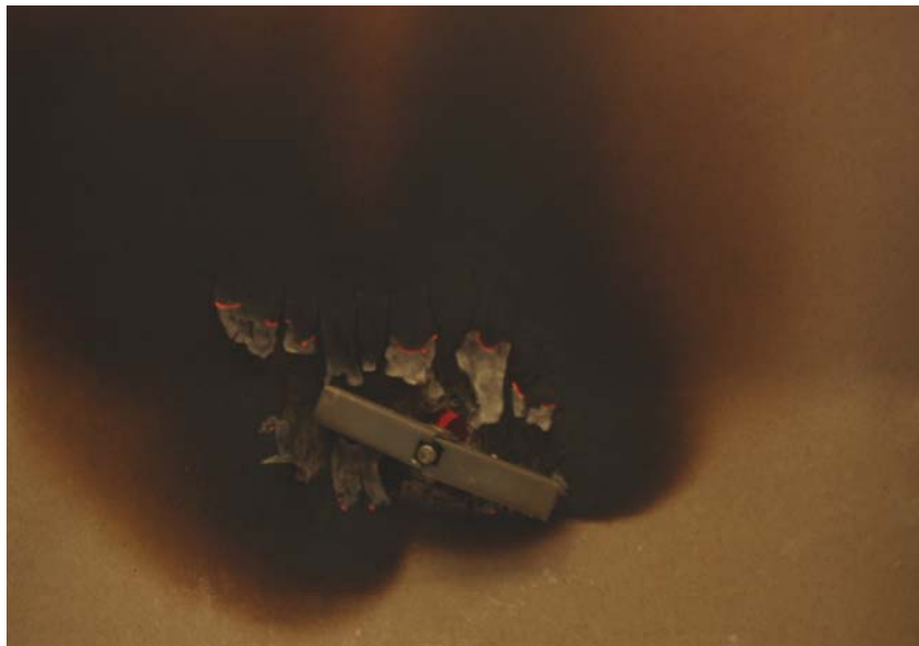
Abbildung 36: Verkohlung auf der Rückseite der Brandschutzbekleidung im Bereich des Klappdübels
