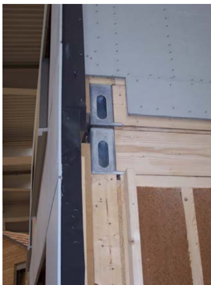
Abbildung 72: Foto der Detailausführung eines Geschossstoßes; Quelle: induo
