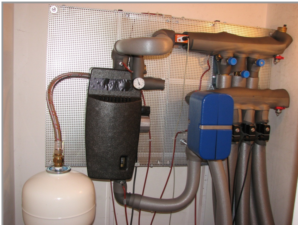
Abbildung 8-1: Kollektoransteuerung am Standort Berlin-Wernsdorf
