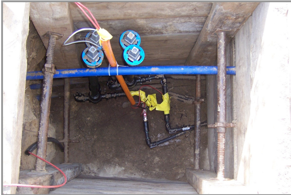
Abbildung 10-2: Anschluss Erdwärmekollektor am Standort Berlin-Nottepfad
