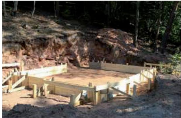
Abbildung 30: Herstellung der Fundamentschalung
