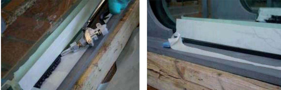
Abbildung 42: Injizieren des Klebstoffes und fertiges Fugenbild
