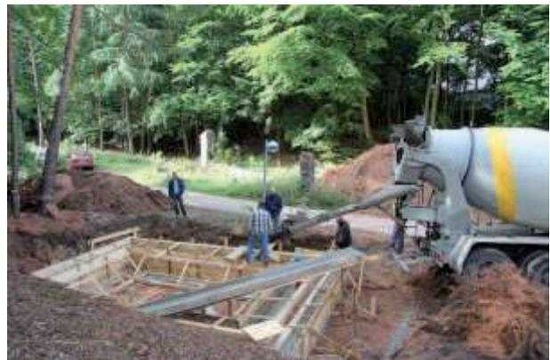
Abbildung 32: Betonage des Köcher-Streifenfundaments
