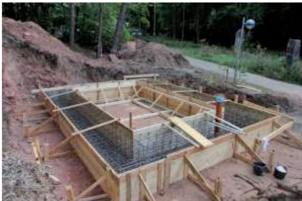
Abbildung 31: Einbau der Bewehrung
