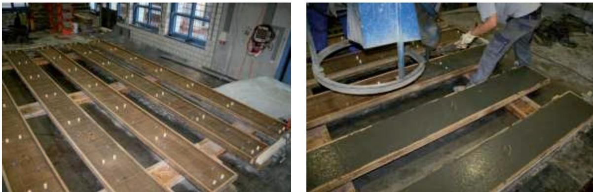
Abbildung 34: Schalung und Betonage der Betongurte
