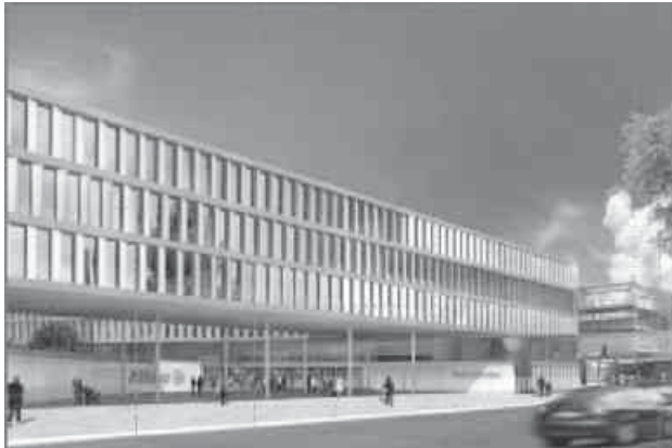
Fig. 2: View of the façade / the main entrance Dieselstraße (Auer+Weber+Assoziierte, architects)
