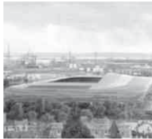
Fig. 2: Grade stade Le Havre, France (copyright Coda- SCAU KSS)
