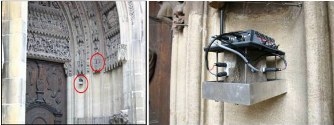
Abb. 27: Fallstudie 2 – Positionierung der Temperatur- und Feuchtesensorik am Portal sowie Impedanzmessung an einem Ersatzprobekörper vor Ort.
