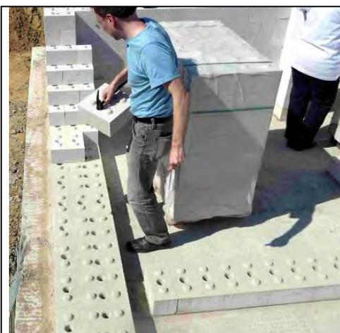
Bild 41 Verlegung der Schichten von Hand
