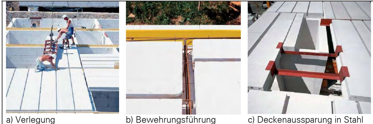
Bild 68 Ringankerausbildung bei Porenbeton-Deckenplatten [204]
