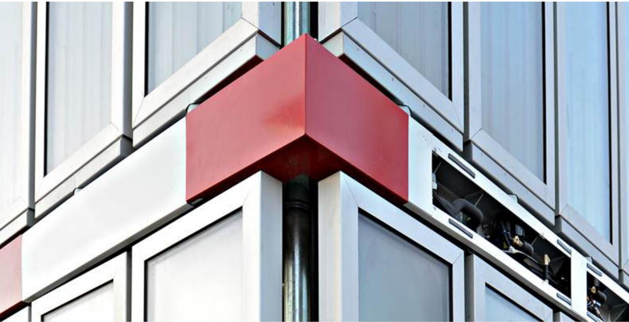
Abbildung 38 zeigt die abnehmbare Blechverkleidung der Unterkonstruktion: links geschlossen, rechts geöffnet mit sichtbaren Versorgungsleitungen
