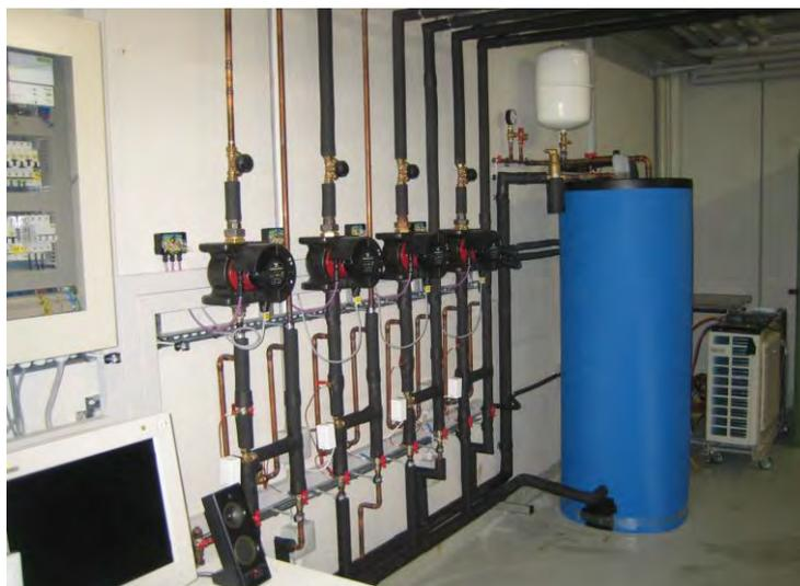
**Abbildung 4.9:** Hydraulisches System zur Kaltwasserversorgung des Fassadenteststands.
