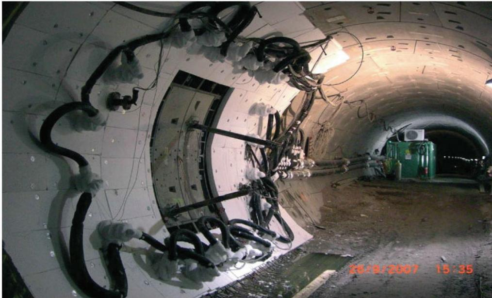
**Abbildung 6.17 Querschlagvereisung mit mobilen Kühlaggregat (Wenke und Willner 2008)**
