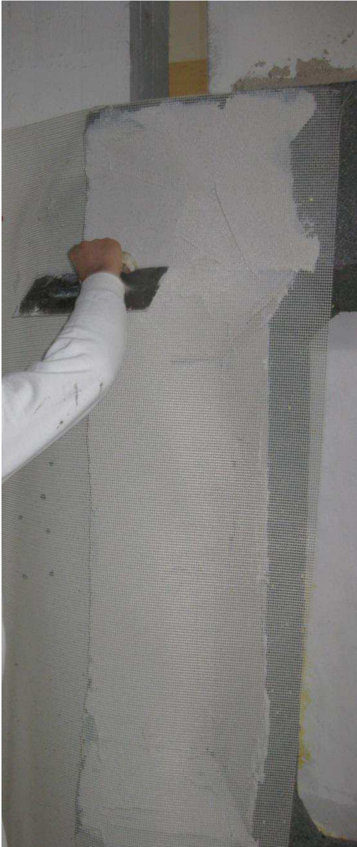
Abbildung 86: Gestaltungsvariante „Polygon“, Aufbringen Gewebe
