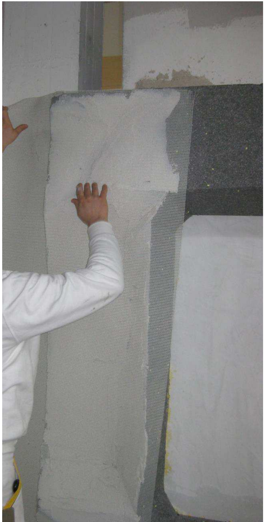
Abbildung 85: Gestaltungsvariante „Polygon“, Aufbringen Gewebe
