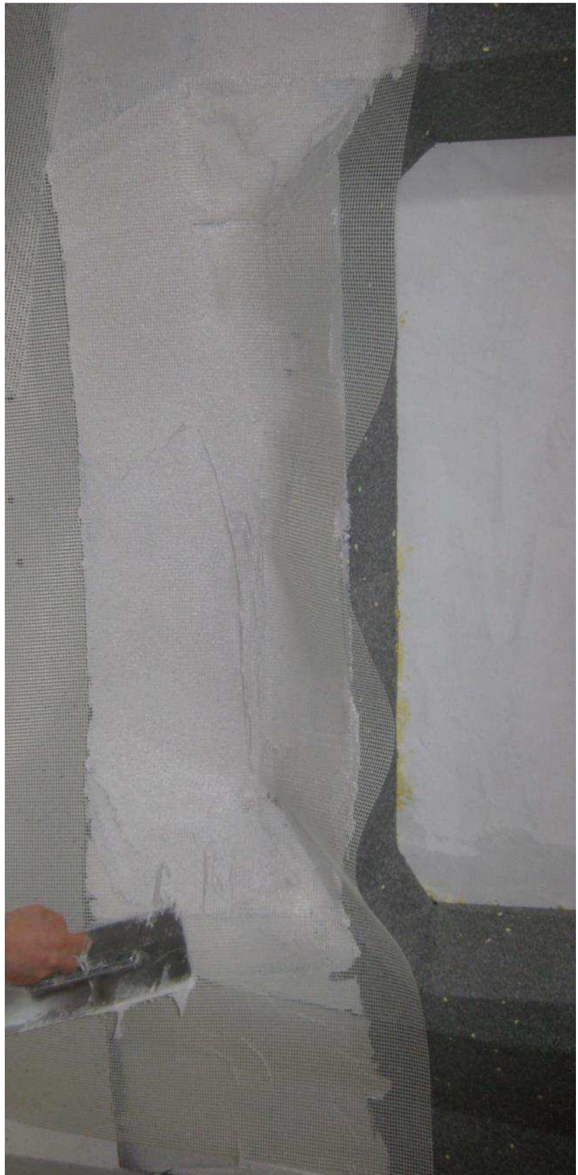
Abbildung 87: Gestaltungsvariante „Polygon“, Aufbringen Gewebe
