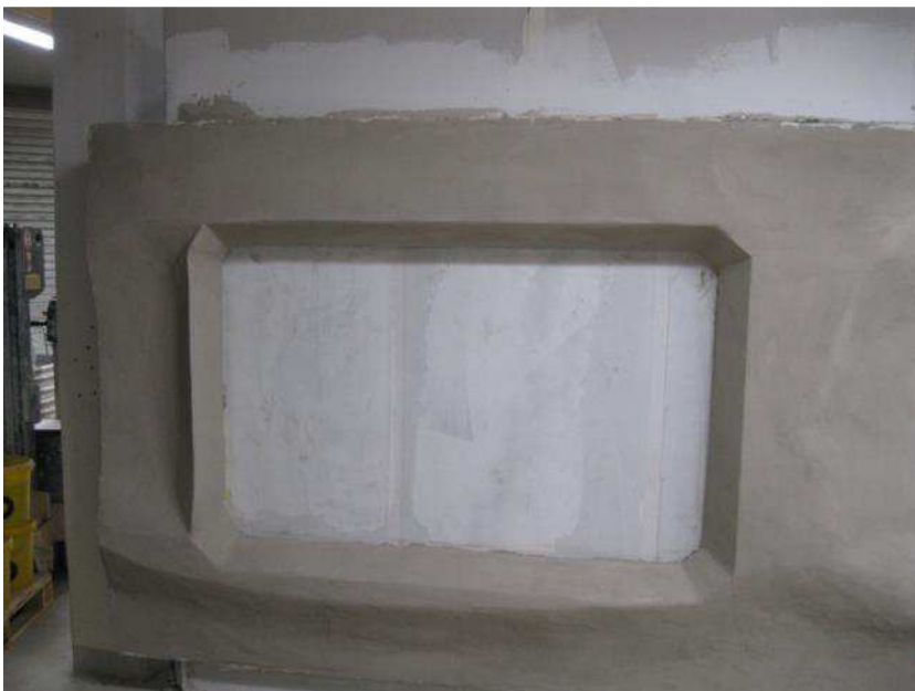
Abbildung 92: Gestaltungsvariante „Polygon“, verputzt, Frontalansicht
