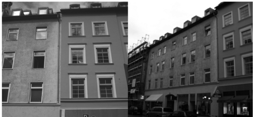
Abbildung 15: Bestandsfassade München Reichenbachstraße
