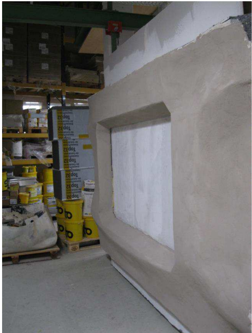
Abbildung 93: Gestaltungsvariante „Polygon“, verputzt, Schrägansicht
