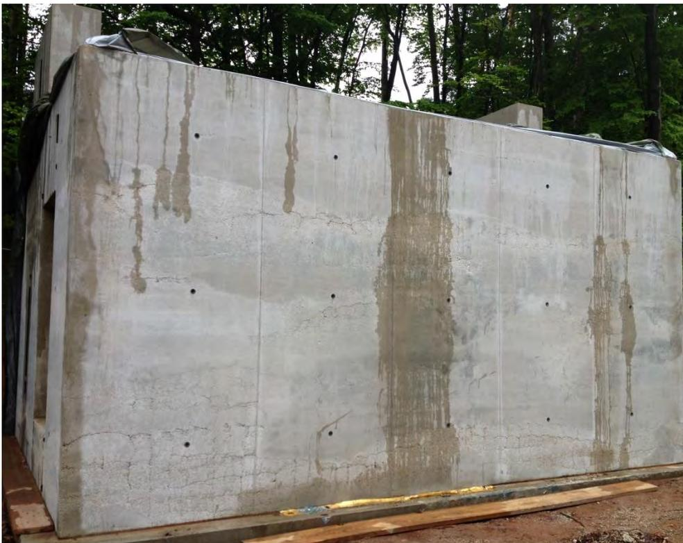
Abbildung 20: Wandfläche aus Architekturleichtbeton
