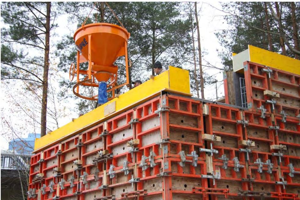
Abbildung 19: Betoniervorgang mit Kübel und Aufsatzkästen (gelb)
