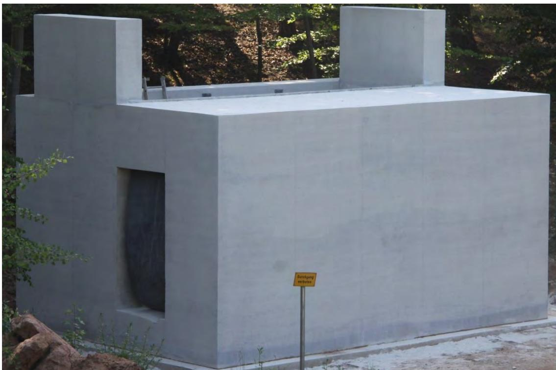
Abbildung 21: Experimentalgebäude aus Architekturleichtbeton nach Abschluss der Betonierarbeiten
