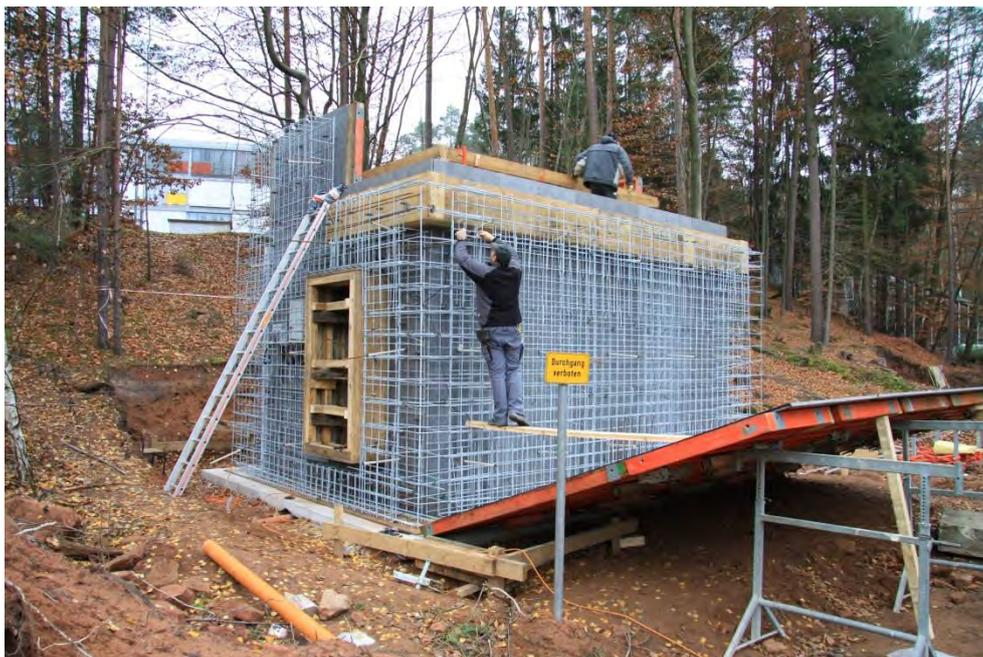
Abbildung 15: Bewehrungs- und Schalungsarbeiten am Experimentalgebäude
