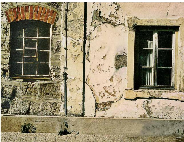
Abb. 8: Bei der Tuffstein-Außenwand eines alten bäuerlichen Anwesens tritt nur im Außenputz des Wohnbereiches aufsteigende Feuchte auf, nicht aber im unverputzten Bereich, trotz höherer Feuchtebelastung (Stall).
