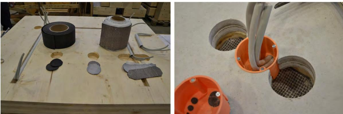
Abbildung 3-21 Einbau von intumeszierenden Brandschutzmaterialien
