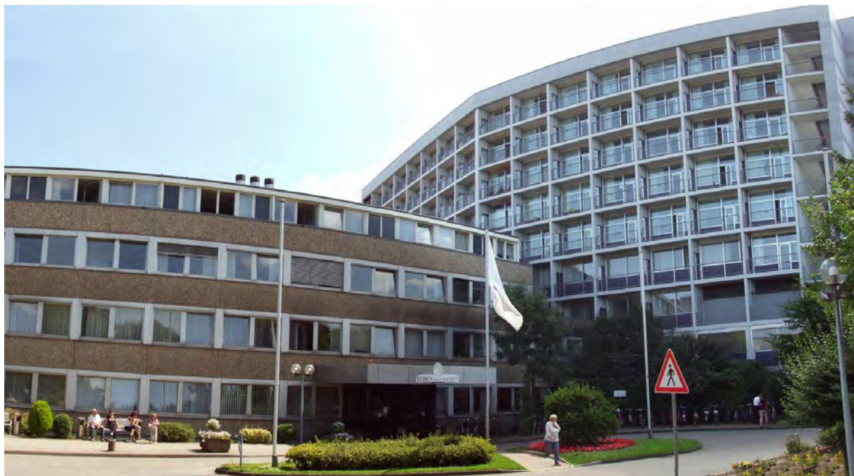
Abbildung 9: Krankenhaus „Luisenhospital Aachen“
