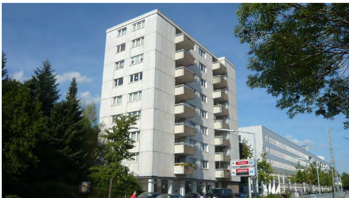
Abbildung 7: Mehrfamilienhaus in Pforzheim, Güterstraße
