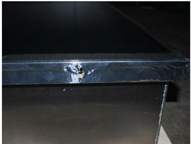
Bild 9 Entlüftungsöffnung im Einleimer
