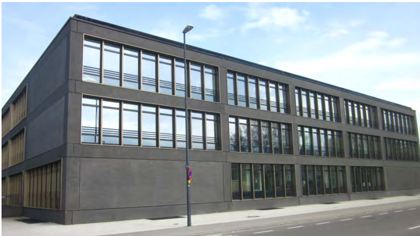
Abbildung 27: Fotos der Nord-, Südwest- und Westansicht der Realschule Memmingen (Quelle: IBP)
