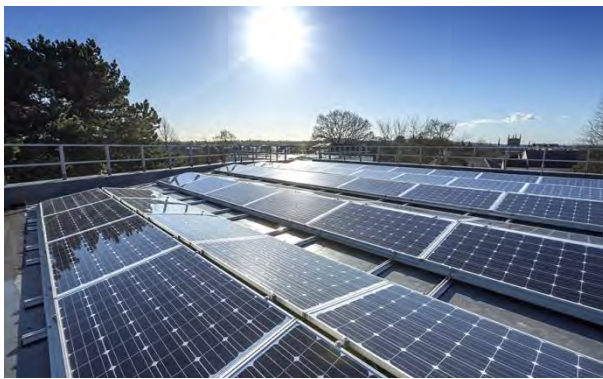
Abbildung 2: Aufdachmontage in Zick-Zack-Aufstellung (Quelle: www.solarworld.de )
