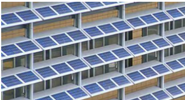
Abbildung 3: Feststehender PV-Sonnenschutz (Quelle: www.baunetzwissen.de )
