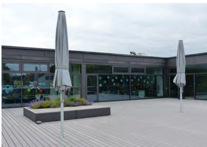
Abbildung 30: Fotos der Süd- und Westansicht sowie einer Dachterrasse der Grundschule Prüfening (Quelle: http://www.schulen.regensburg.de/pruefening )
